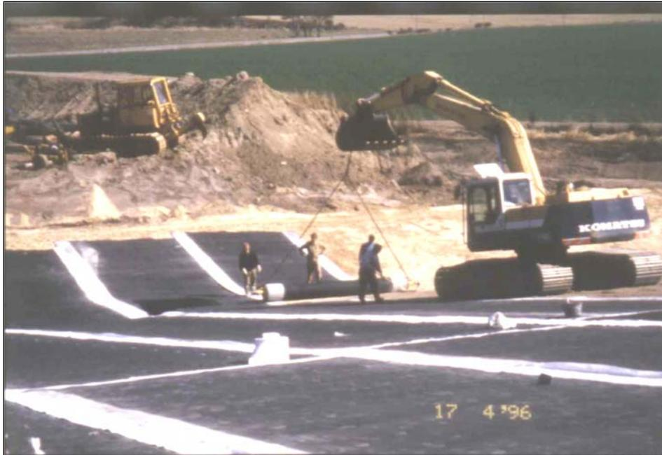
**Abb. 2:** Einbau der geosynthetischen Tondichtungsbahn (GTD) als Teil der Oberflächenabdichtung der Deponie Neu Wulmstorf, Nähe Hamburg, 1996/97
