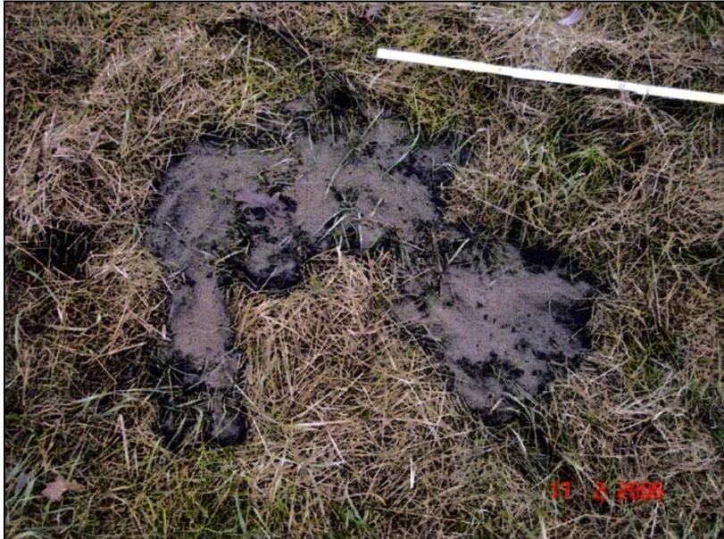
**Abb. 3:** Bodenauswaschung nach Ausströmen von Druckwasser entlang eines Maulwurfsganges im Böschungsfuß der Deponie Neu Wulmstorf (Melchior, 2010).
