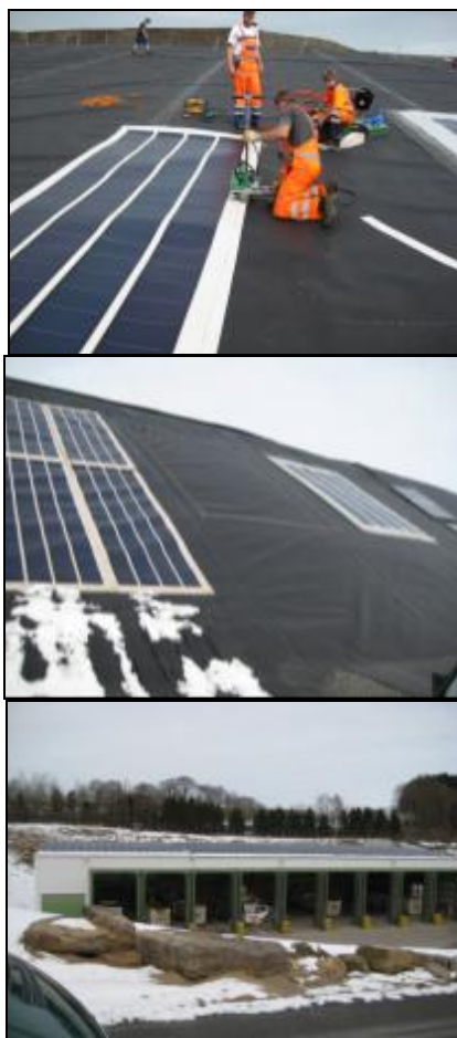
Abbildungen 12-14: Montage der SolarDachbahn mit einem Adapterstreifen; verschiedene Solartestsysteme auf der Versuchsanlage Deponie Leppe; Vergleichsfeld kristalline Silizium-Solarmodule
