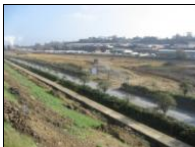
Abbildungen 1-3: Die Deponie Malagrotta vor der Installation des SolarDachbahn-PV-Systems.
