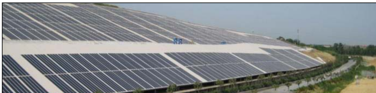
Abbildung 4: Die Deponie Malagrotta mit der PV-Installation (gleiche Ansicht wie das Foto in der Mitte oben)
