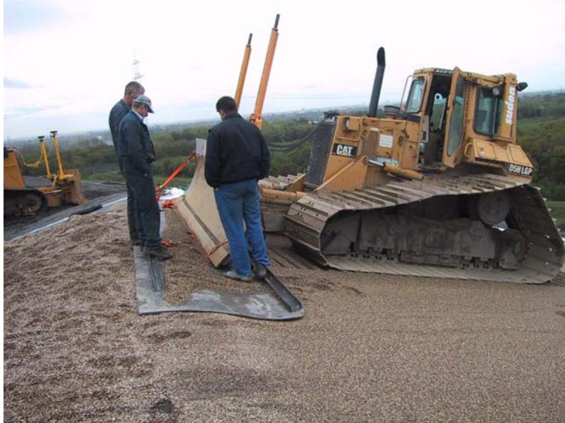
Eine Deponie in Niedersachsen: Auch hier wird eine Kapillarsperre über einer Kunststoffdichtungsbahn eingebaut. Von Anfang an gute Leistungen und gute Qualität, niedrige Baukosten und eine kurze Bauzeit.
