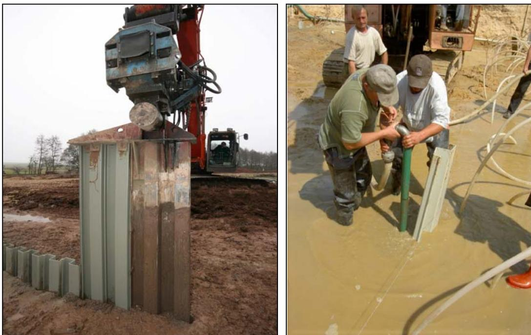
**Abbildung 2:** Li: Einbau mit Mutterbohle, Re: Einbringhilfe mittels Spülverfahren
