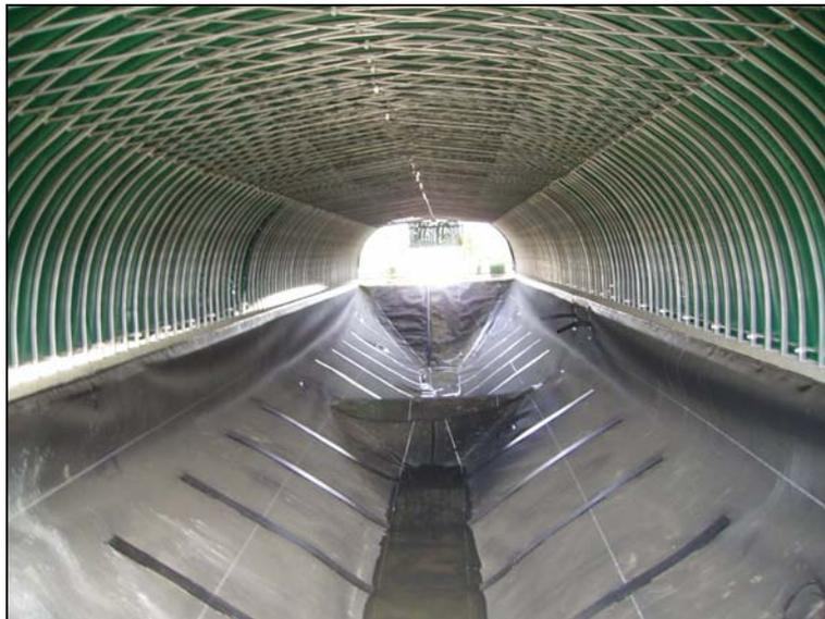
**Bild 7:** Sickerwasserbecken Uberdacht
