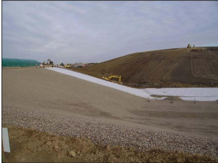
**Bild 3:** Bau einer DK-I-Deponie am Fu einer Altdeponie
