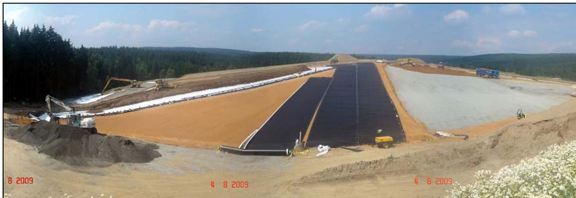
**Bild 8:** Oberflachenabdichtung (Kombinationsbauweise) in der Baudurchfuhrung
