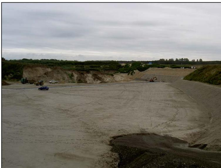
**Bild 2:** Vorbereitung einer ehemaligen Sandgrube zur Errichtung einer DK-I-Deponie
