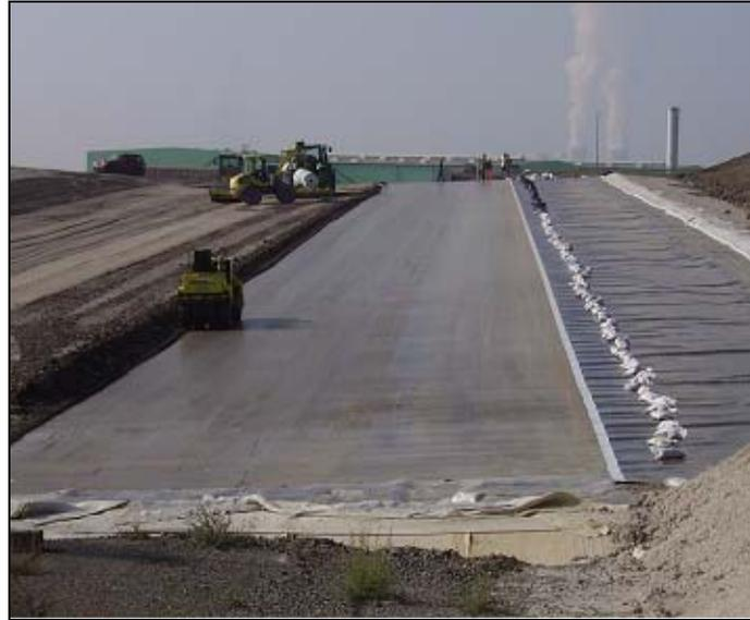
**Bild 1:** Situation beim Bau einer klassischen Kombinationsabdichtung fur eine Deponiebasis
