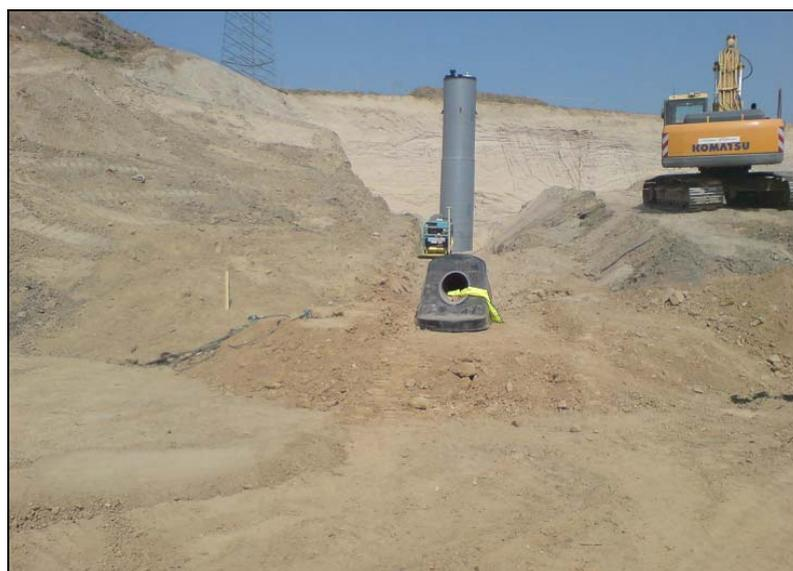
**Bild 6:** Einbau eines Sickerwasserschachtes und der Durchdringung bei einer DK-I-Deponie
