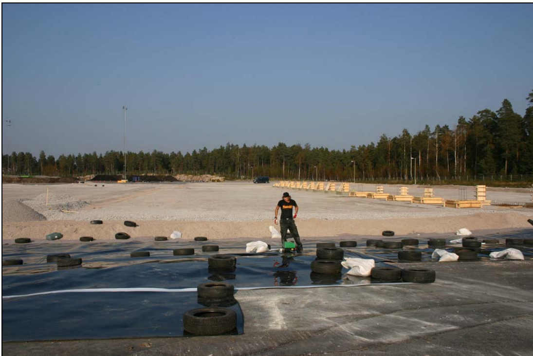
Abb. 2: Verschweißung der Carbofol® Kunststoffdichtungsbahn
