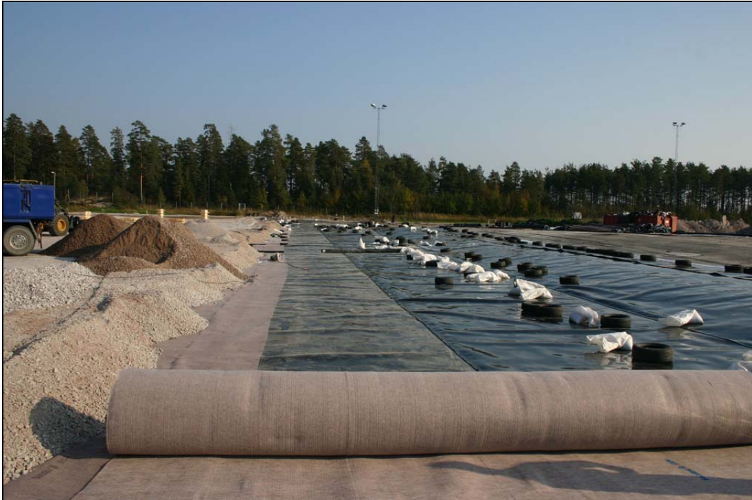
Abb. 3: Verlegung eines Secutex® Schutzvliesstoffes über der Kunststoffdichtungsbahn
