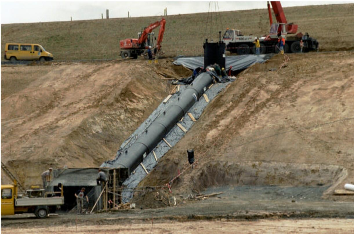
**Abbildung 4:** Gesamtbauwerk vor Verfüllung
