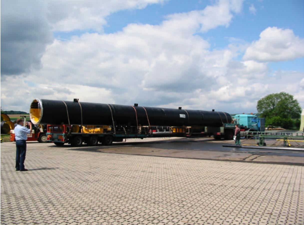
**Abbildung 2:** Transport eines vorgefertigten Schrägschachtes DN 1600, Länge 23,4 m.
