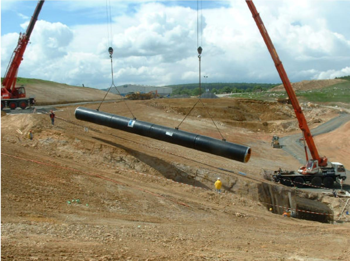
**Abbildung 3:** Montage Schrägschacht DN 1600
