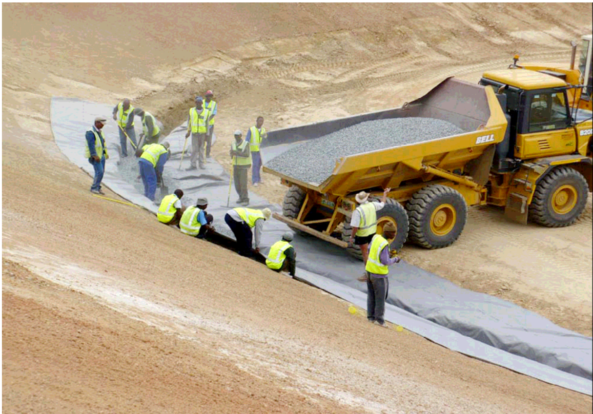
Abb. 19: Erhöhter Personaleinsatz bei Erdarbeiten (Herstellung der Basisfußdränage)
