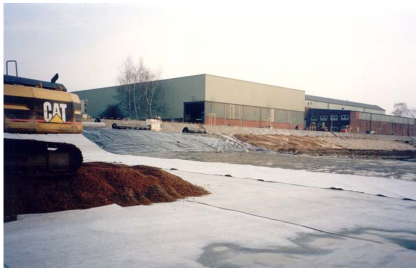
Abb. 3: Beckenabdichtung in der aufgehöhten Basisfläche
