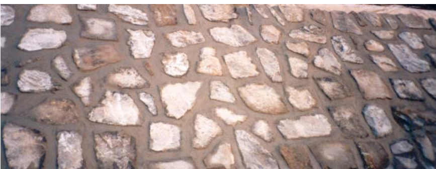
Abb. 4: Ertüchtigung des südlichen Böschungsdeckwerks
