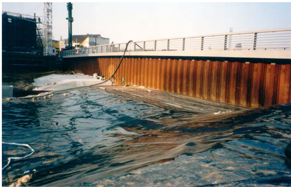
Abb. 9: Anschluss der Basisabdichtung an die Spundwand
