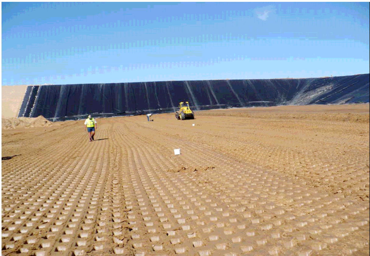
Abb. 21: Verdichtungsarbeiten an der Deponiebasis
