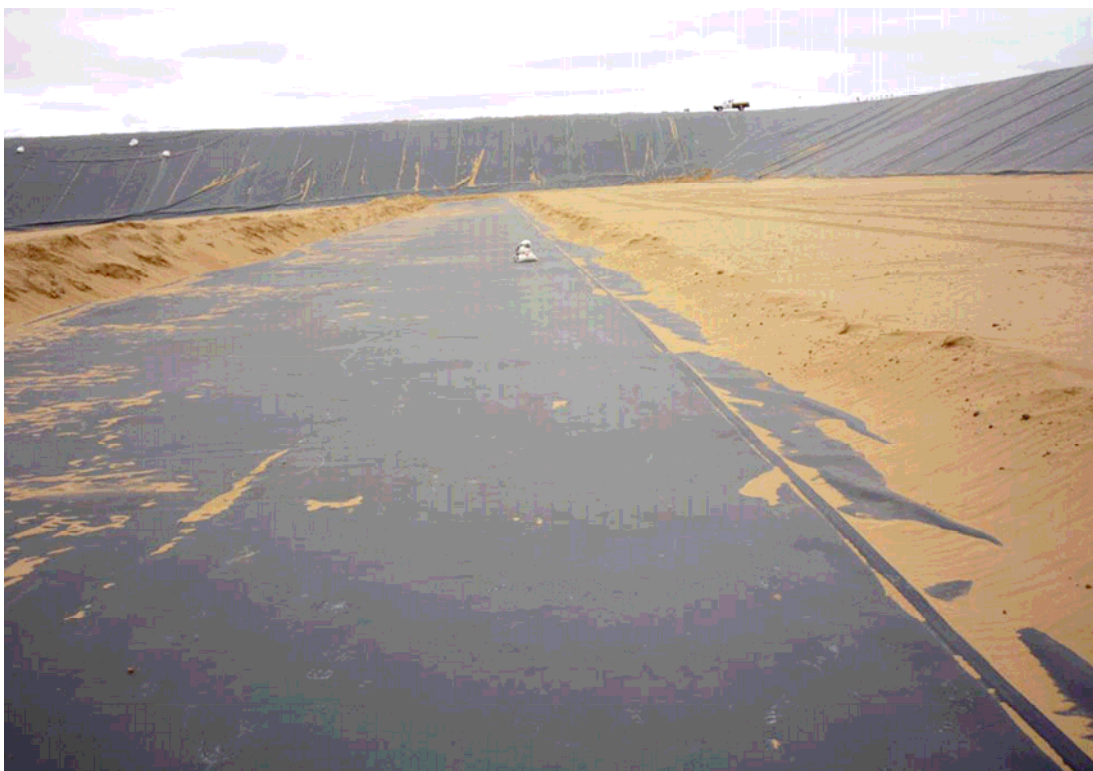
Abb. 22: Kunststoff-Dichtungsbahnen als wesentliche Systemkomponenten in guter Planlage
