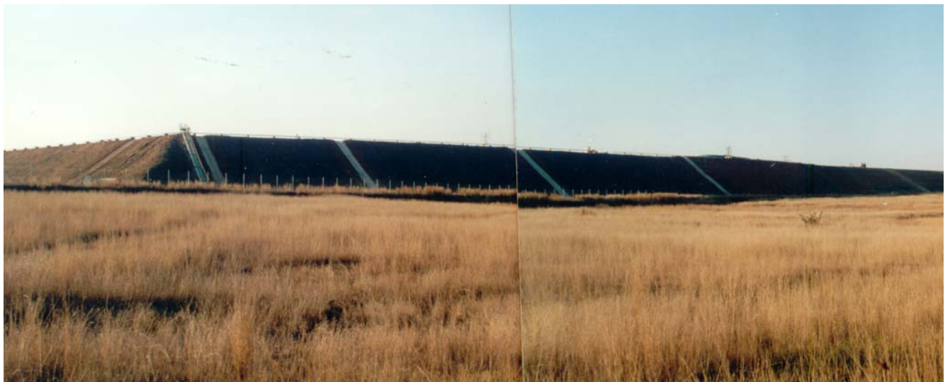
Abb. 17: Luftseite des südlichen Abschlussdammes
