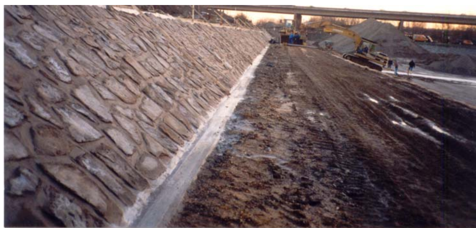
Abb. 6.: Böschungsaufbau nördliches Ufer
