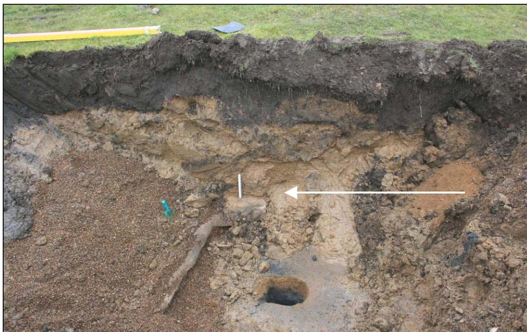
**Bild 7:** Aufgeweichter Unterboden über dem Filtervlies (Pfeil)
