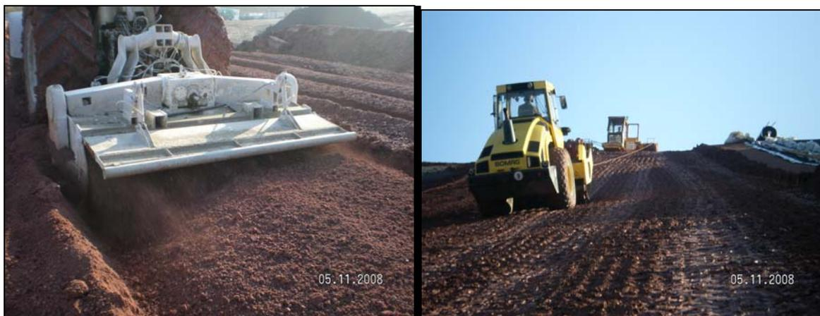
**Abb. 8** Tonaufbereitung und Einbau der Mineralischen Dichtung im Steilbereich
