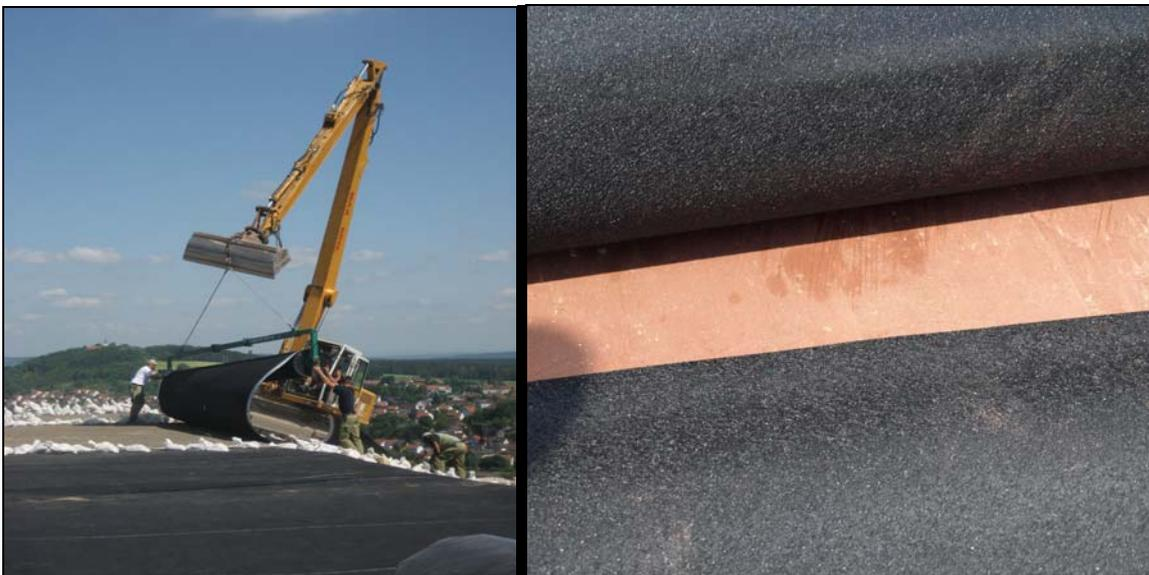
**Abb. 9** Verlegung der KDB im Pressverbund mit der mineralische Abdichtung
