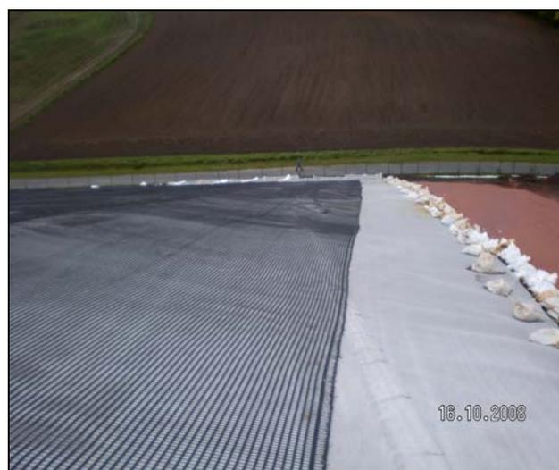
**Abb. 10** Zugbewehrung im Steilbereich auf der Drainagebahn Quelle: Max Bögl
