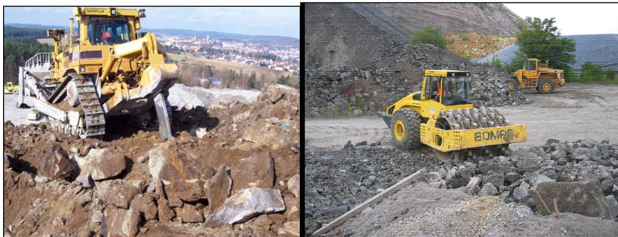
**Abb. 7** Lösen und Zerkleinern der Schlacken Quelle: Baudienststelle Schlackenberg und Max Bögl
