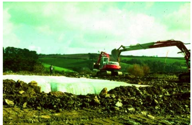
Bild 4: Aufwölben des Stabilenka® bei teilweiser Zuschüttung im Randbereich
