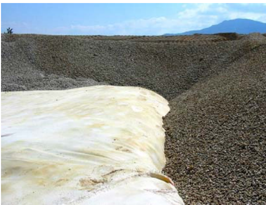
Bild 17: Projekt „Viscofan“ - Aufbringen der ersten Bodenschicht (Foto HUESKER)
