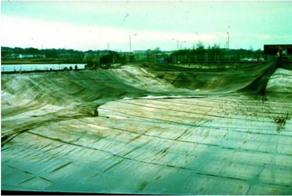
Bild 1: Installation von vorgefertigten Stabilenka® Großpanels mit Seilen
