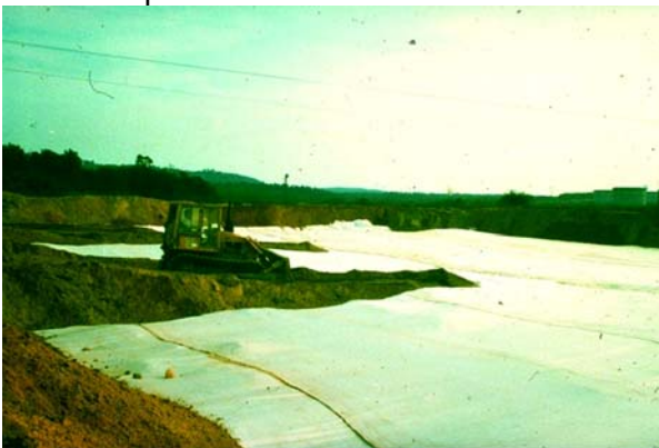
Bild 3: Zungenweise Einbringung der ersten Bodenlagen
