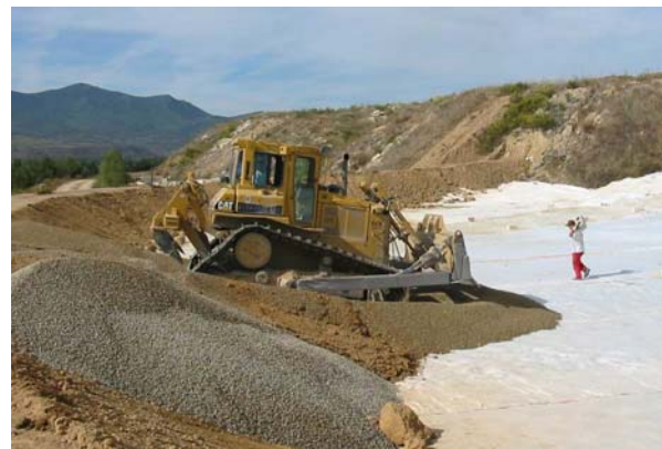
Bild 17: Projekt „Viscofan“ - Aufbringen der ersten Bodenschicht (Foto HUESKER)
