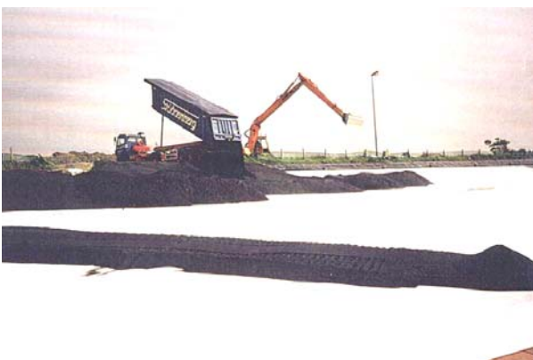
Bild 9: Galing I: Einbau der ersten Bodenlage auf dem Comtrac® (Foto Matthäi, Westerstede)
