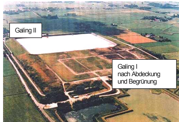
Bild 12: Die Jarosit-Schlammdeponie Galing I nach der Abdeckung
