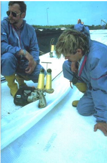
Bild 7: Galing I: Vernähen der Comtrac®-Bahnen (Foto HUESKER)
