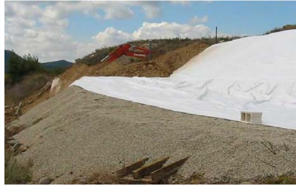
Bild 15: Projekt „Viscofan“ - Verankerung der Bewehrungslage im existierenden Randdeich (Foto HUESKER)
