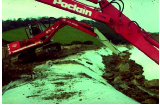
Bild 2: Einrichten des „sludge locks“ am Teichrand
