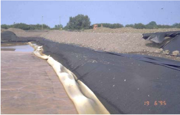
Bild 11: Galing I: Blick auf den Frontbereich des mehrschichtigen Oberflächenabdichtungssystems (Foto HUESKER)
