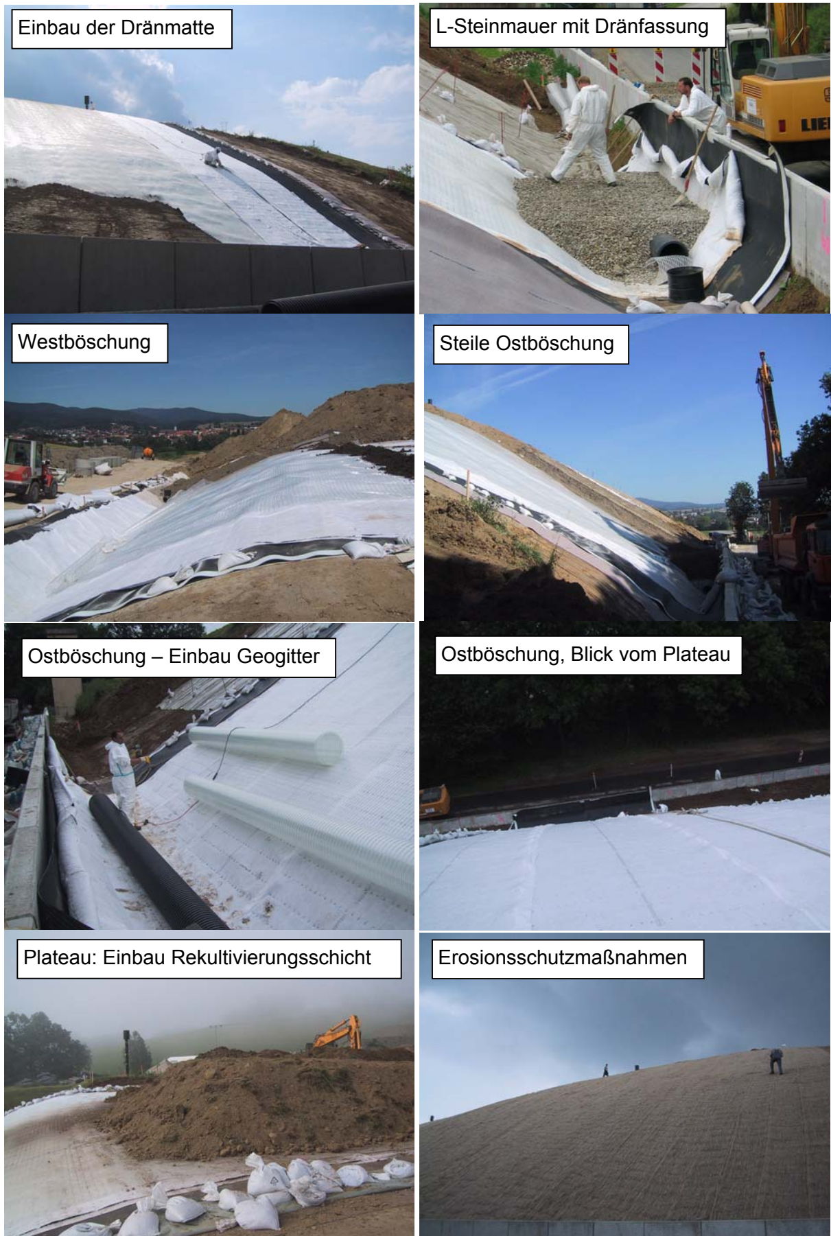
Abb. 3: Deponie Furth im Wald: Einbau des Dichtungssystems aus Geokunststoffen
