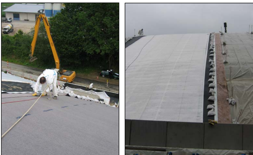
Abb. 1: Sanierung der Oberflächenabdichtung Deponie Furth im Wald
