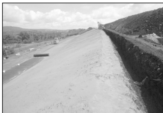
Abb. 8: Tiefankergraben Dillinger Hütte
