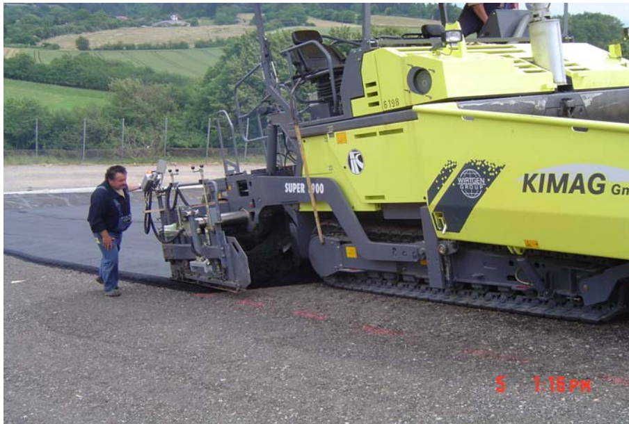
Abb. 3: Fertiger bei der Herstellung einer Bahn der Asphaltabdichtung.
