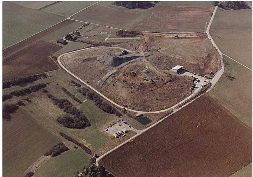
Abb.: 4 Luftbild der Deponie vor Beginn der Arbeiten
