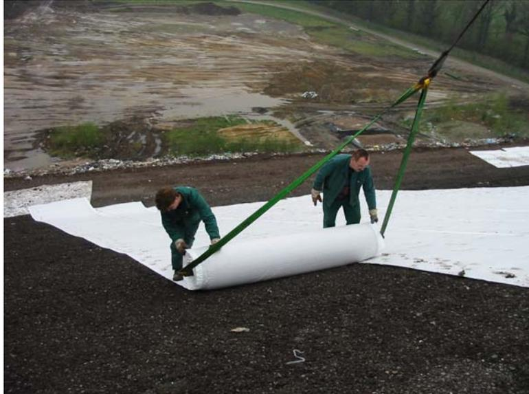
**Bild 3:** Abrollen der Sandmatte auf der Böschung 1:2
