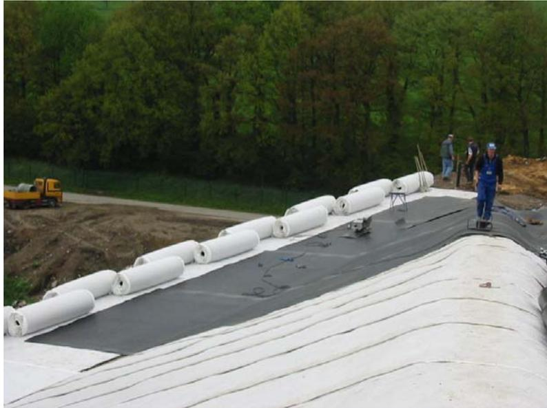
**Bild 4:** Positionierung der Sandmatten auf der Berme für die Verlegung auf der Böschung 1:1,2
