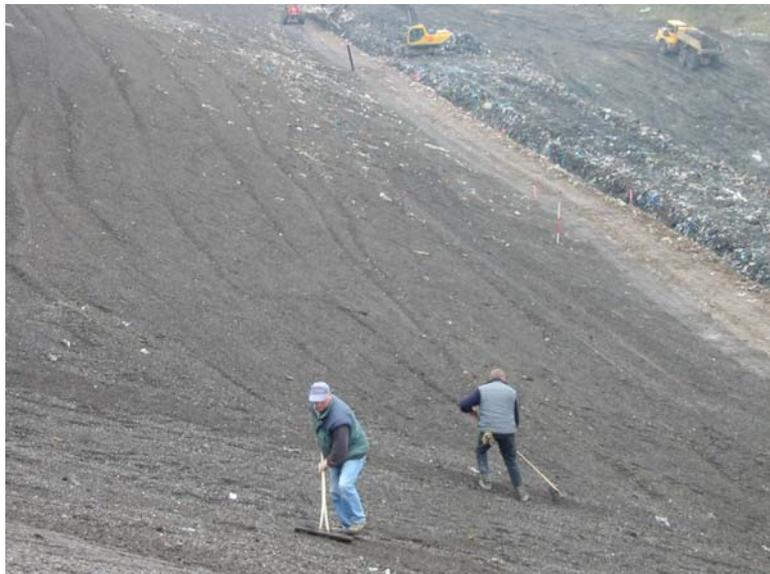
**Bild 2:** Nacharbeiten der Auflagerschicht aus Glasbruchmaterial
