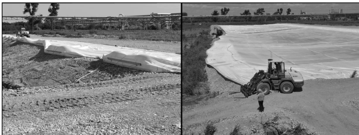
**Abb. 4.5 a, b:** Vorbereitetes Panel und Abdeckung Becken 2 mit ca. 16.000 m<sup>2</sup> Geokomposit
