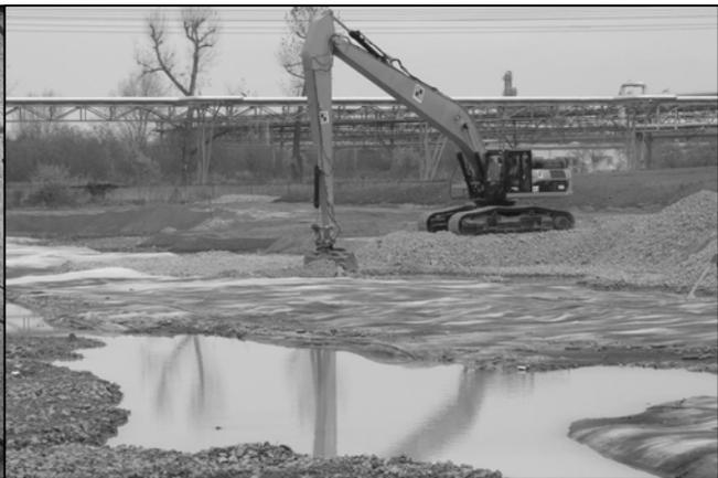
**Abb. 4.7:** Verfüllung mit Langarmbagger
