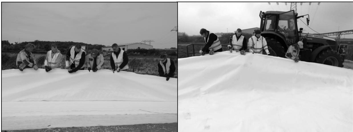
**Abb. 4.3 a, b:** Vernähen der Geokompositbahnen: Links zu Fuß, rechts auf der Nähbühne
