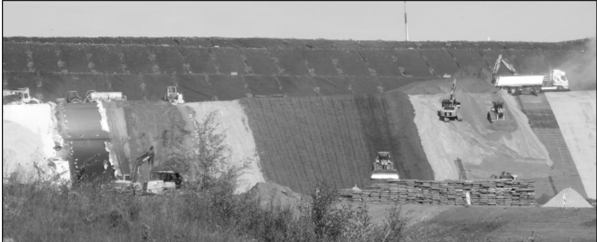
**Abb. 3.4:** Einbauphasen der MFA im Böschungsbereich mit Neigung 1:3
