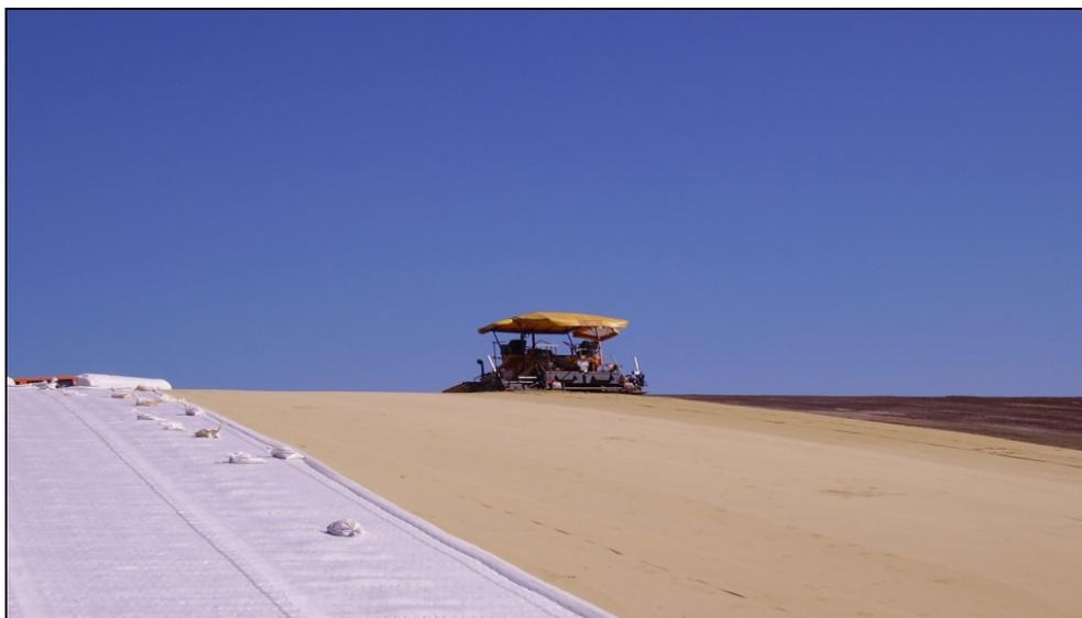
**Bild 19:** Bau von TRISOPLAST® mittels Strassenfertiger Halde Freiberg
