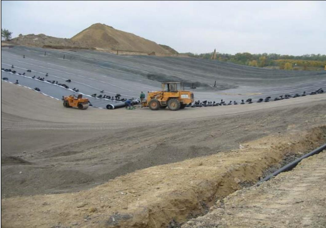
**Abbildung 12:** Verlegung KDB und Einbau Flächenfilter im 1. Bauabschnitt (Oktober 2007)
