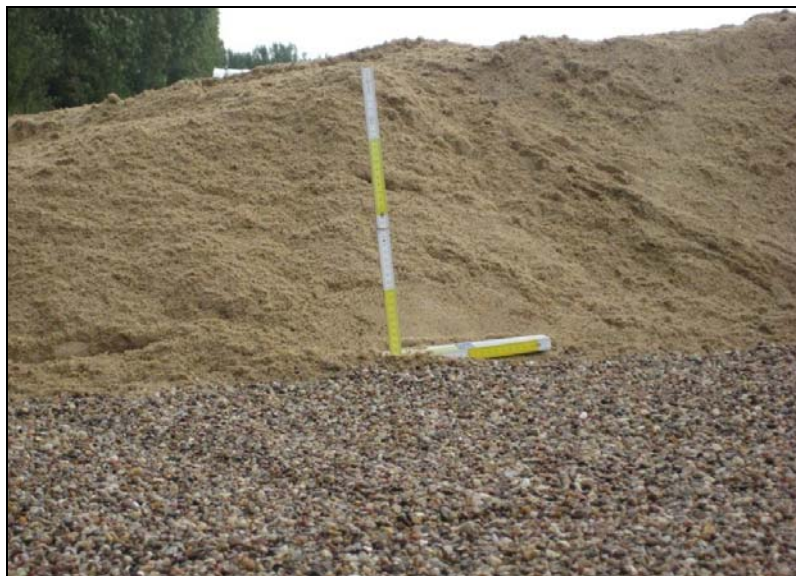
Bild 11: Einbau Kapillarschicht auf Kapillarblock (Testfeld Wieringermeer)
