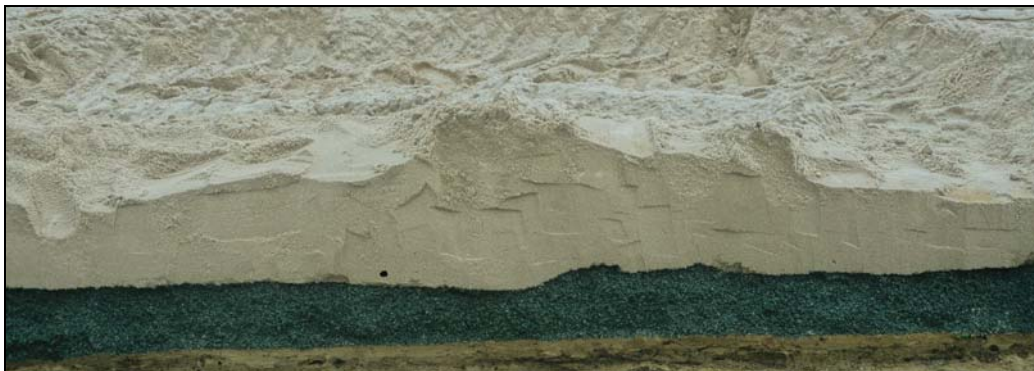
Bild 8: Überprüfung der Ebenheit der Schichtgrenze zwischen Kapillarschicht und -block im Probefeld nach einem Wendemanöver der Raupe auf der Kapillarschicht um 180°
