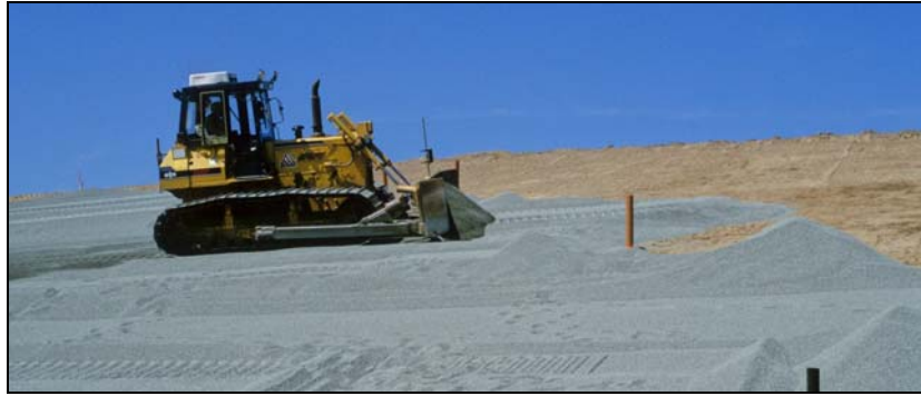
Bild 10: Einbau Kapillarblock mit Raupe (Kapillarsperre Deponie Breinermoor)
