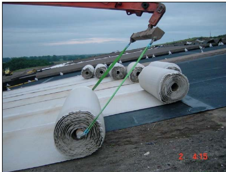
Bild 12: Ausrollen Kapillarblockbahnen (Versuchsfeld Deetz)
