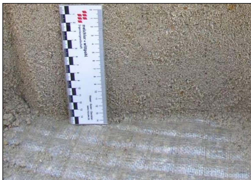
Bild 13: Kapillarschicht auf Kapillarblockbahn (Versuchsfeld Deetz)
