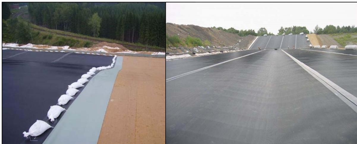
**Abbildung 11:** Vorbildlicher Einbau einer Oberflachen- und Basisabdichtung
