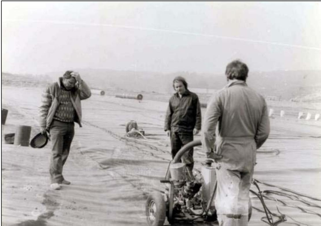
**Abbildung 8:** Probeeinbau und Verschweiung einer PE HD Platte an einer Deponie, 1988
