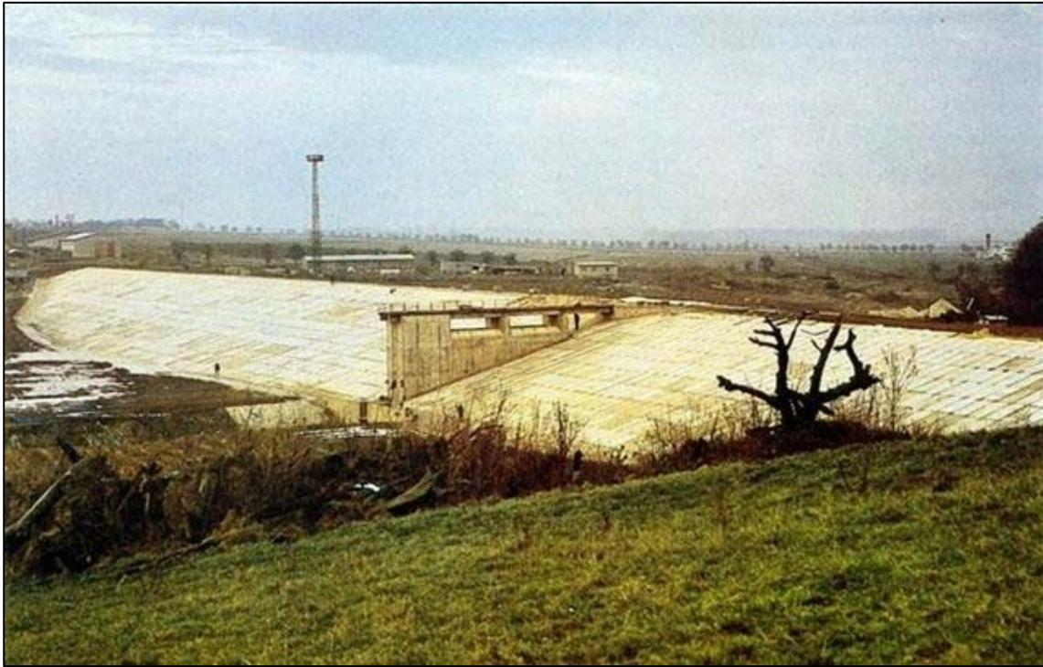
**Abbildung 3:** Talsperre Hopfgarten mit PVD-w Dichtungsbahn 1977, kurz vor der Fertigstellung
