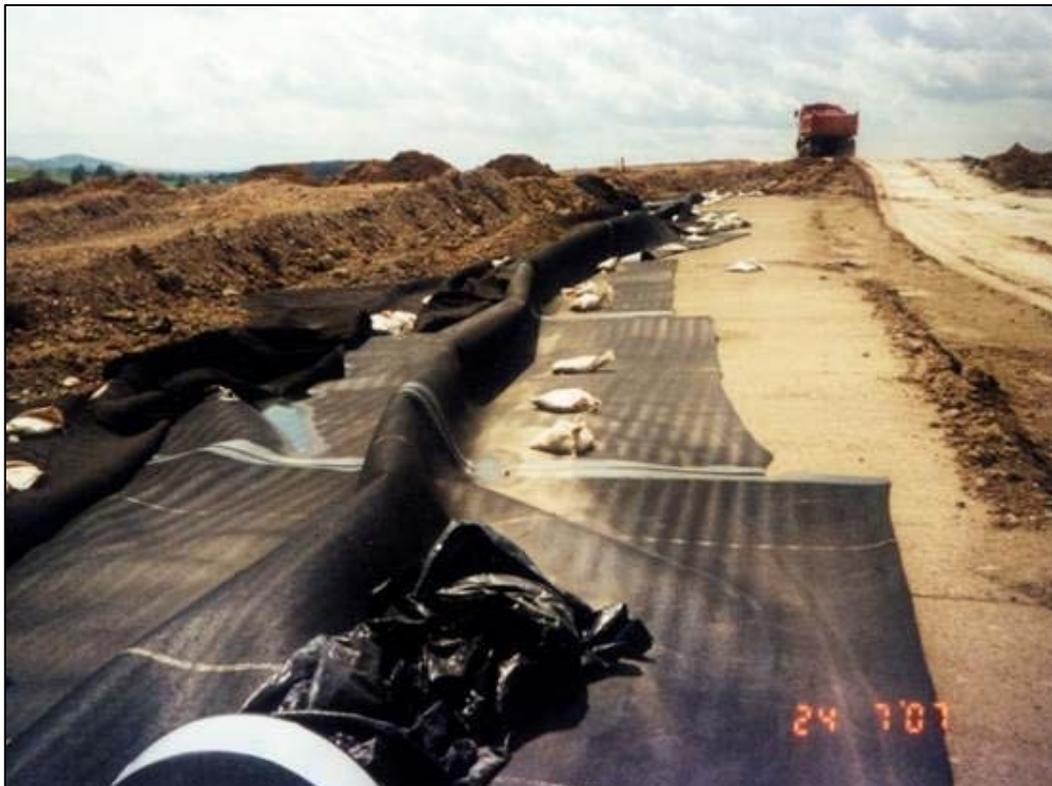
**Abbildung 9:** Schadensbild beim Einbau einer PE HD Bahn nach einem Sturm
