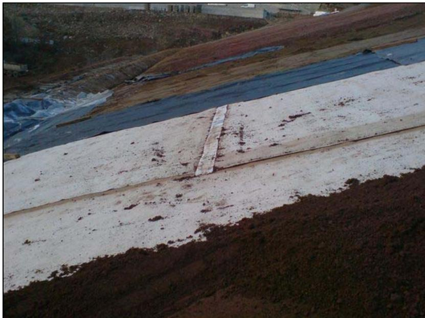
**Abbildung 7:** Einbau einer Bentonitmatte am Hochwasserruckhaltebecken Glashutte
