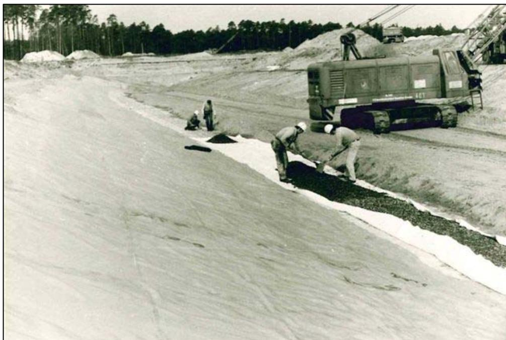
**Abbildung 5:** Einbau einer Dichtungsbahn mit Auftriebssicherung an einer Flussverlegung
