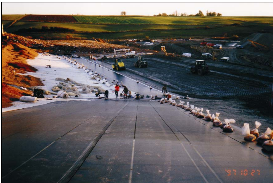
Abb. 9: Mit der Riegelbauweise können Dichtungsbahnen im Winter und Sommer wellenfrei verlegt werden [30].
