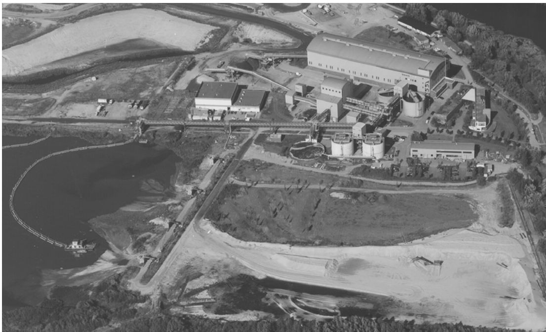
Bild 3: Luftaufnahme Baggergutbehandlungsanlage METHA
