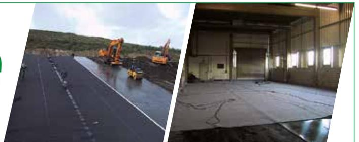
Abdichtungsarbeiten mit Kunststoffdichtungsbahnen und Geokunststoffkomponenten, wie Schutzvliesen, Geogittern, Drainagematten, Bentonitdichtungsbahnen im Deponie-, Tief- und Landschaftsbau und bei Bauwerksabdichtungen.
