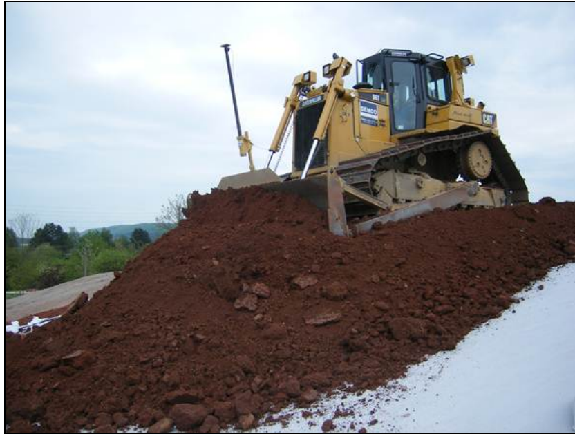
Abb. 2: Einbau Rekultivierungsschicht
