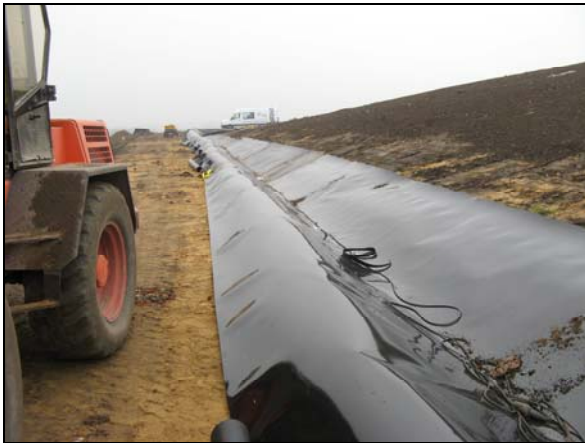
Bild 13: Bremengraben bei der Herstellung
