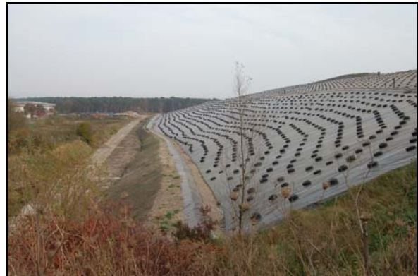
Bild 6: Böschung fertig gestellt
