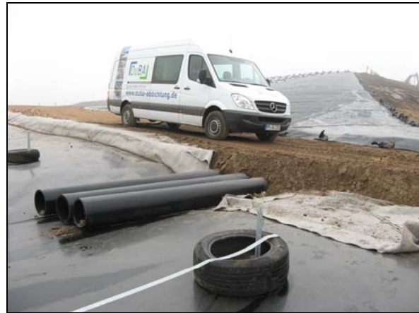
Bild 14: Abschlag Bermengraben, 3 DN 300
