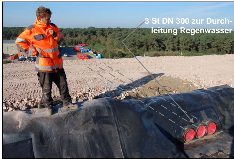
Bild 9: Einbindung 3 DN 300 in Randgraben
