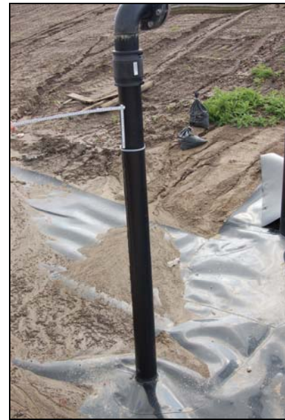
Bild 10: Einbindung Gasbrunnen
