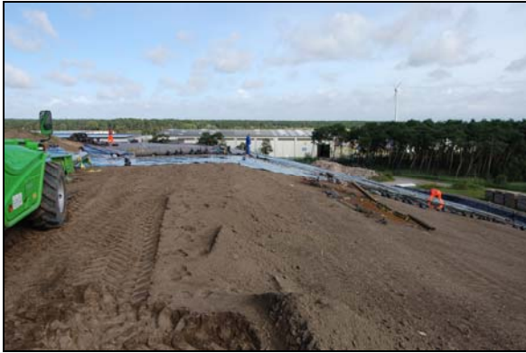
Bild 3: Einbau Ausgleichsschicht, KDB
