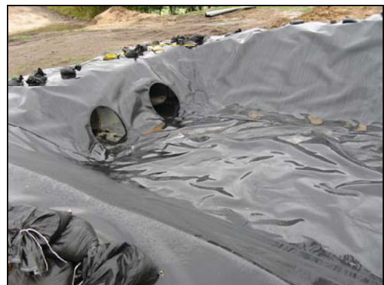
Bild 8: Einbindung 800-er Durchlässe
