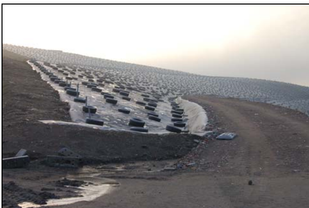
Bild 7: Bermenweg mit Randgraben
