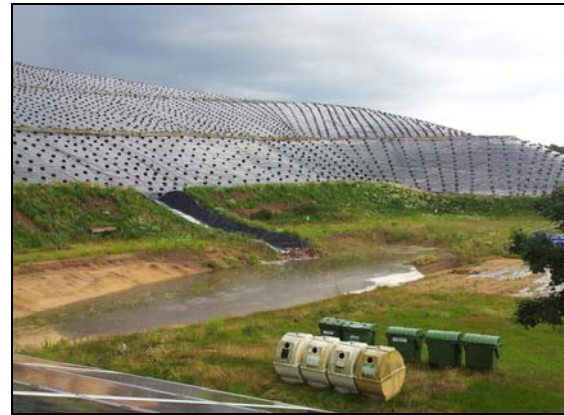
Bild 20: Lagesicherung KDB durch Reifen
