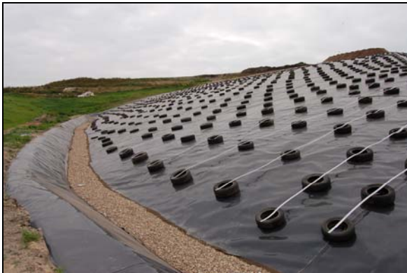
Bild 5: Randgraben mit Kies gefüllt
