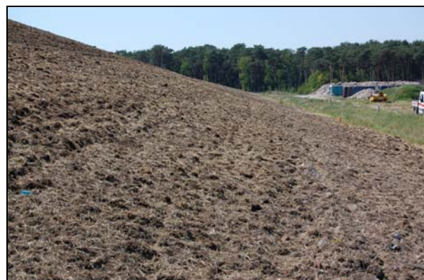
Bild 2: Böschung nach Fräsübergang
