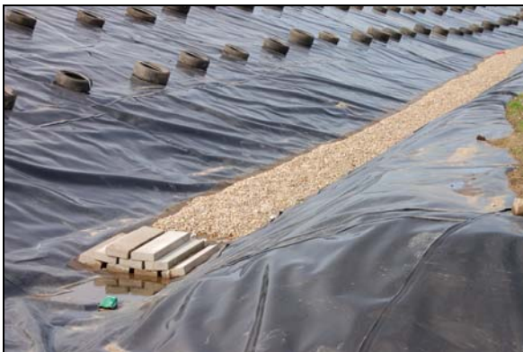
Bild 17: Ballastierung Randgraben, Kies
