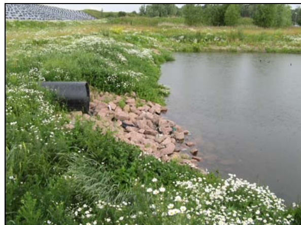
Bild 16: Auslauf ins Versickerungsbecken
