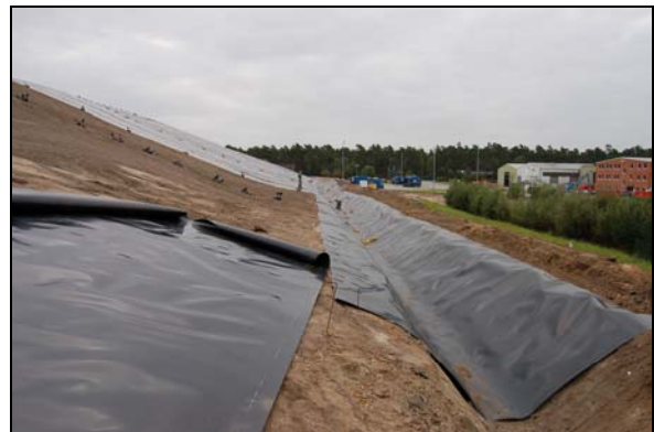
Bild 18: Separate KDB zur Grabenauskleidung
