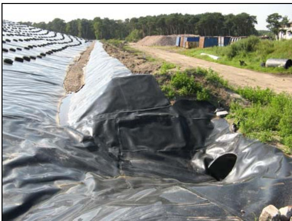
Bild 15: Einlauf Randgraben, 800-er Durchlass
