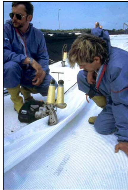
Abb. 8: Galing I: Vernähung des Geoverbundstoffes Comtrac® 100/150 B30
