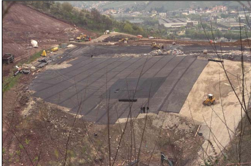
Abb. 6: Deponie Einöd: Bewehrung der Unterlage für die Zwischenabdichtung mit PVA-Geogittern- fast fertig
