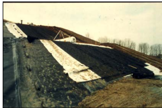
Abb. 15: Übersichtsaufnahme der steilen Deponieböschungen in der Bauphase
