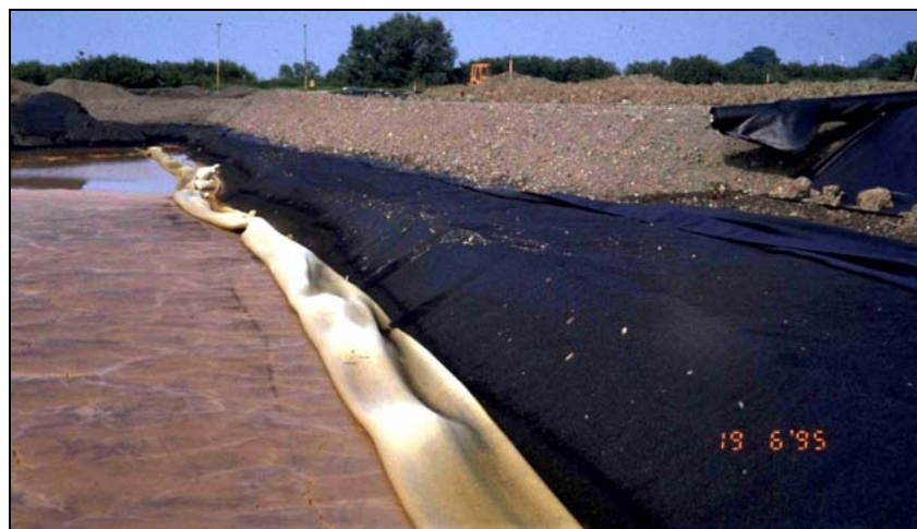
Abb. 9: Galing I: Aufbau des Elfkomponentensystems (Teilansicht) auf dem Jarositschlamm
