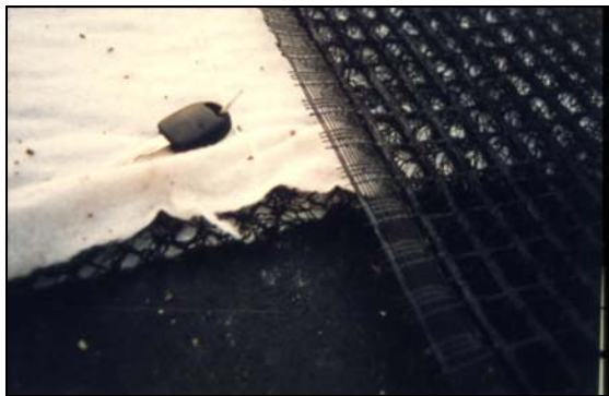
Abb. 14: Detailaufnahme des Aufbaus auf der Kunststoffdichtungsbahn
