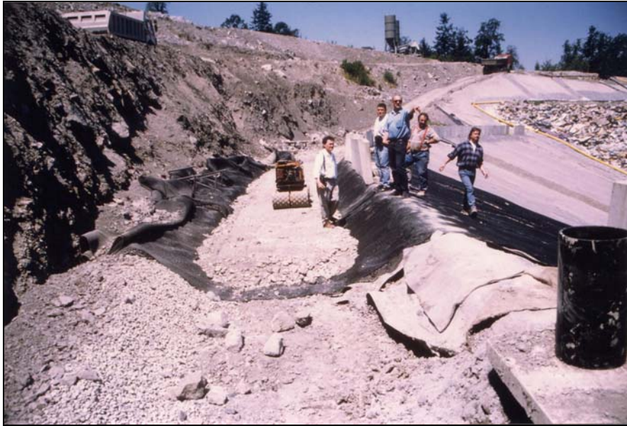
Abb. 4: Verlegung der Geogitter Fortrac® R 1200 A und Ankergraben
