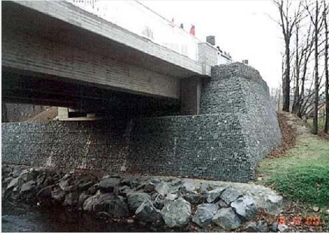
Widerlager aus geokunststoffbewehrter Erde bei der Ilsebrücke (Huesker/IBH)
