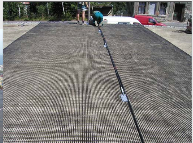
Extensometereinbau
