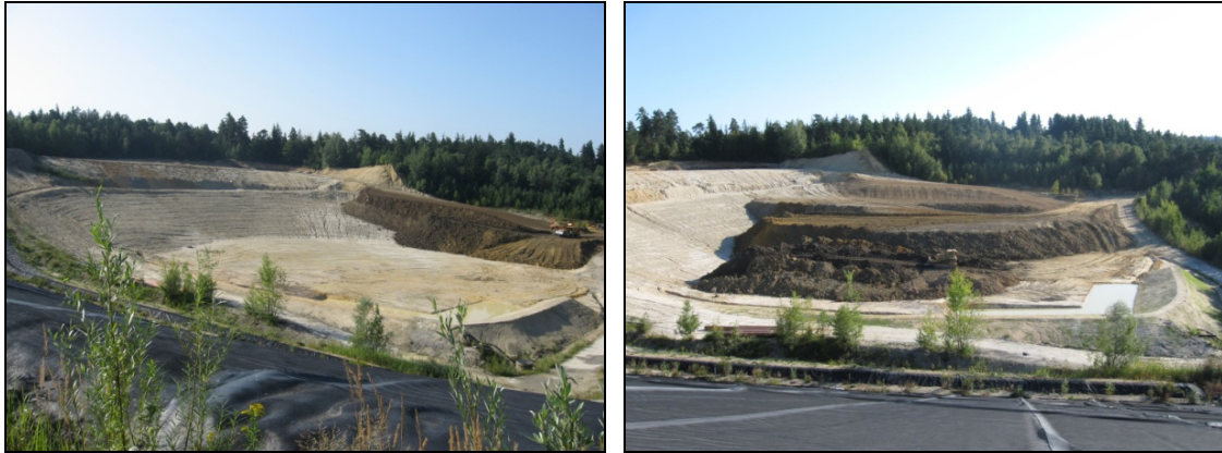
Abb. 9: Verfüllung Bodenlager (gesamt ca. 70.000 m 3 )
