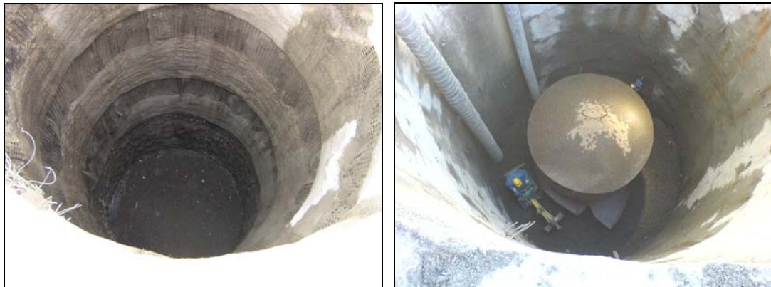
Abb. 3: Herstellung von bis zu 40 m tiefen Sanierungsbaugruben im Abfallkörper
