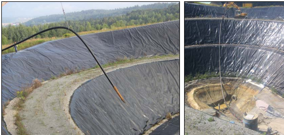
Abb. 4: Einführung Berstrakete mit neuem Sickerwasserrohr in die Startgrube
