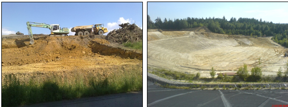
Abb. 8: Bodenabtrag und Vorbereitung Bodenlager
