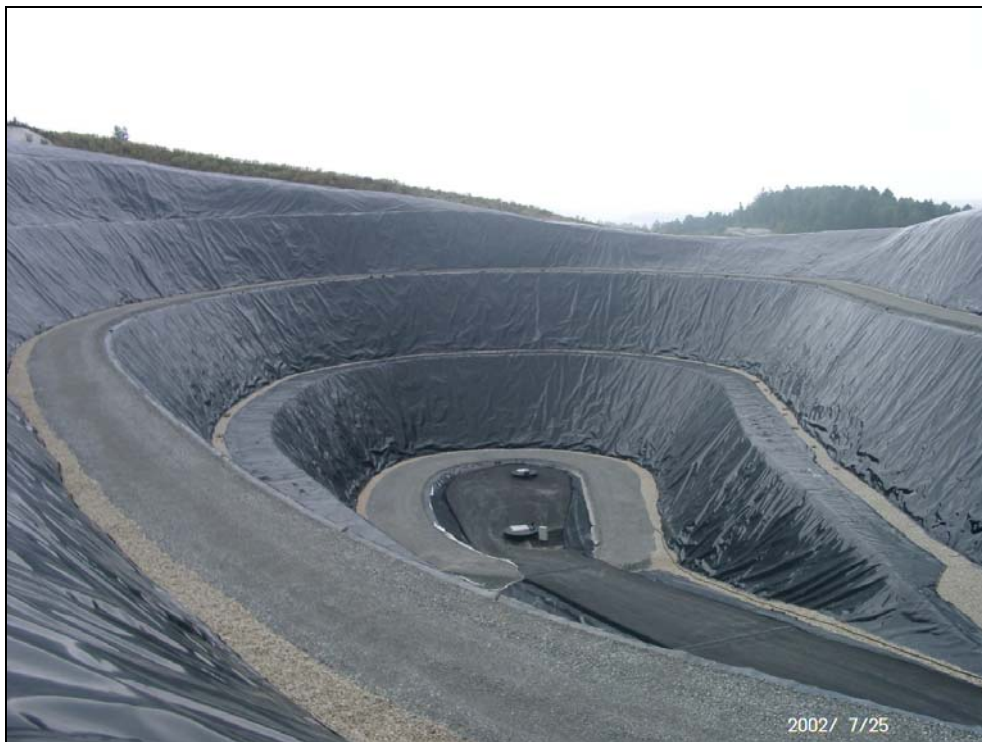
Abb. 6: Baugrube vor der Rückverfüllung
