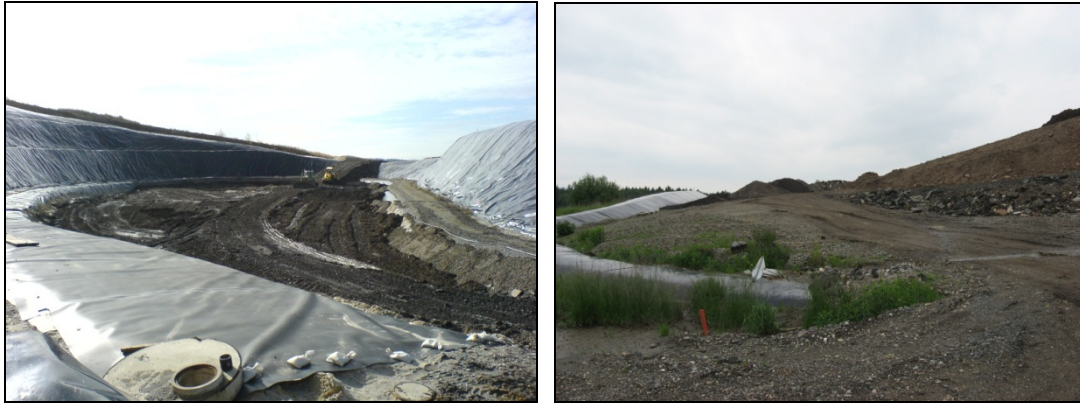
Abb. 7: Baugrube teilrückverfüllt/rückverfüllt
