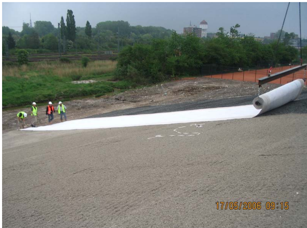
Bild 1: Verlegung der Bentonitmatte
