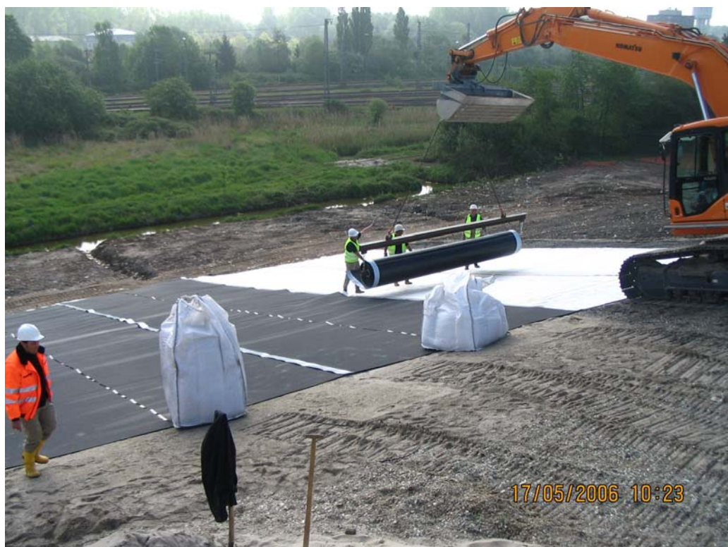
Bild 3: Verlegung der Kunststoffdichtungsbahn
