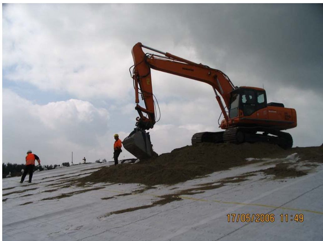
Bild 4: Verlegung der Dränmatte
