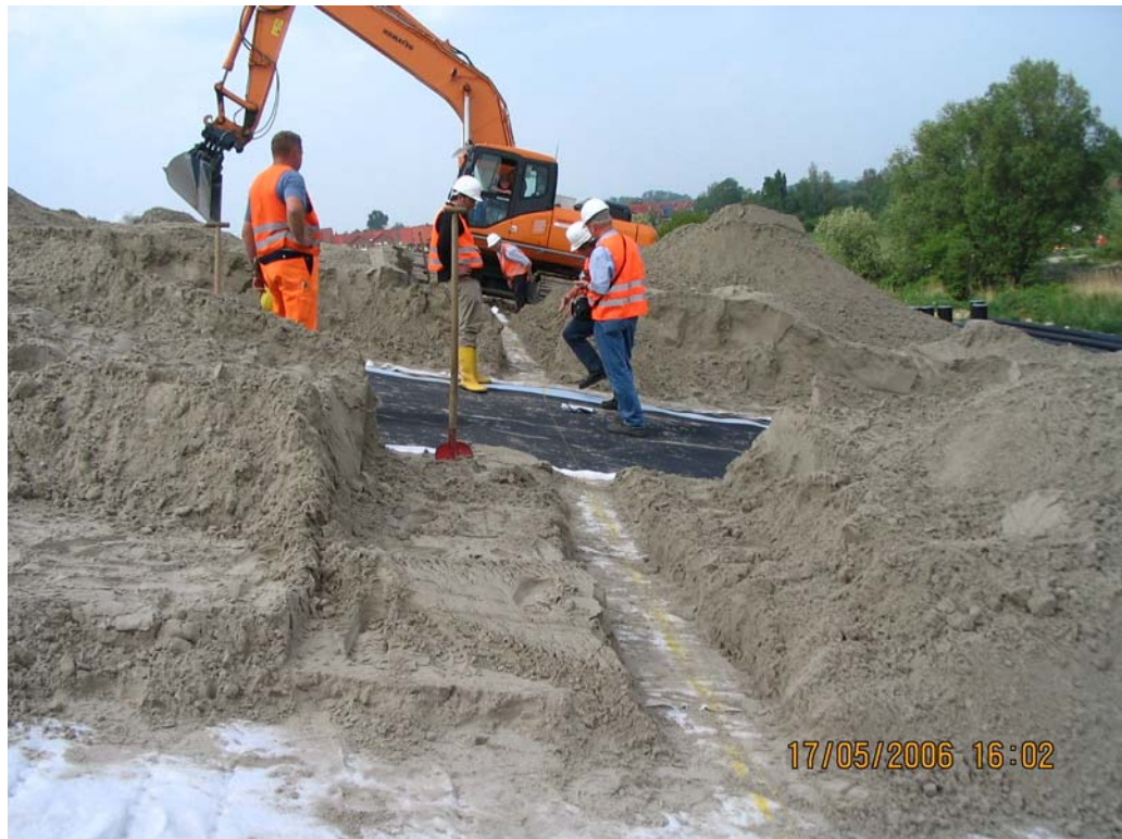
Bild 8: Freilegung des Abdichtungssystems
