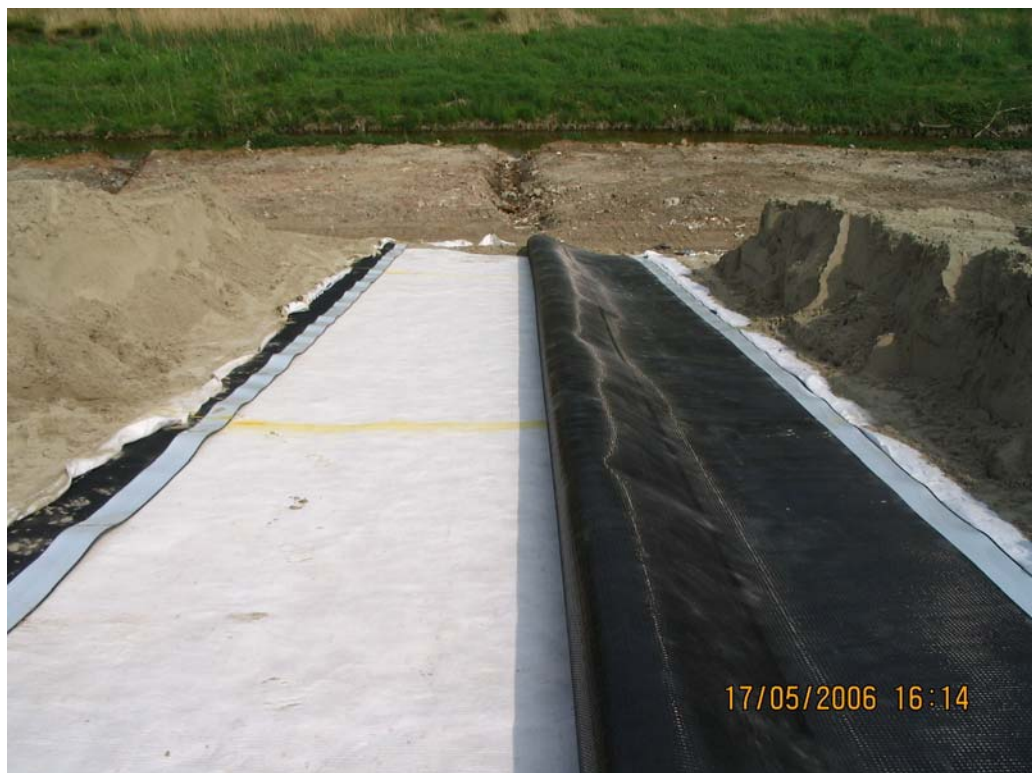
Bild 9: Freigelegte Kunststoffdichtungsbahn und Dränmatte
