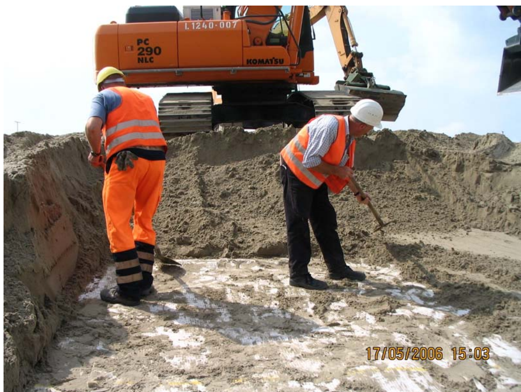
Bild 7: Freilegung des Abdichtungssystems
