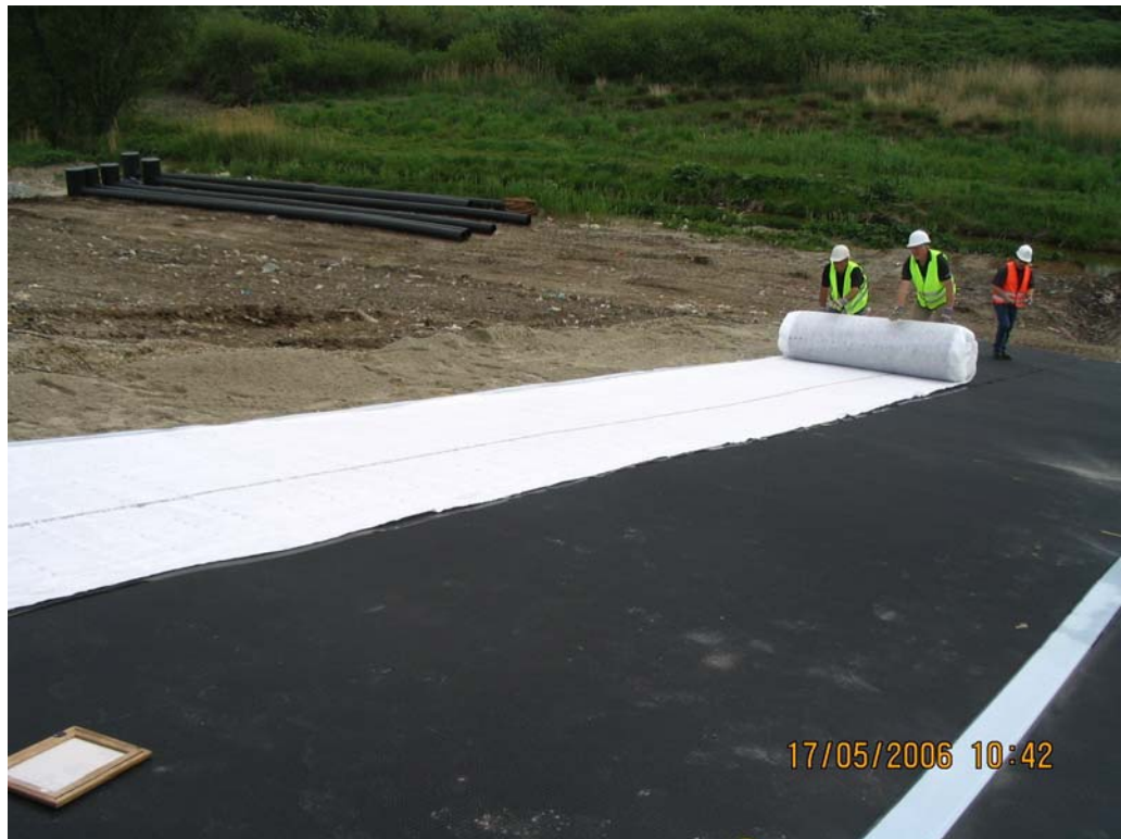
Bild 4: Verlegung der Dränmatte
