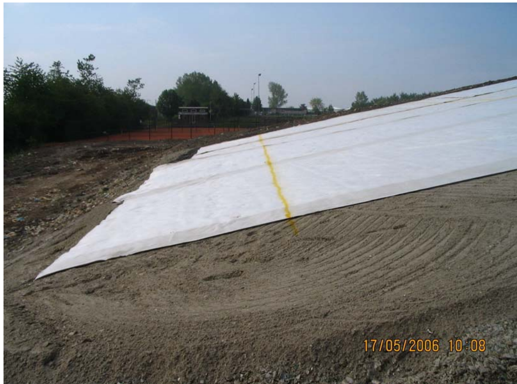
Bild 2: Markierung auf der Bentonitmatte
