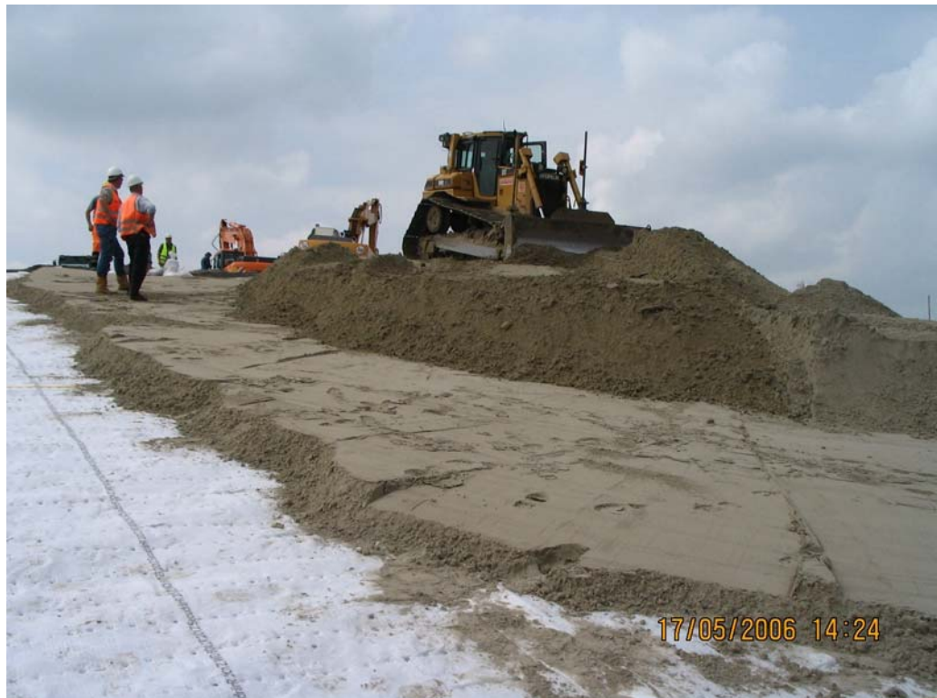
Bild 6: Aufbringen der Vegetationsschicht (Simulation mit Sand)
