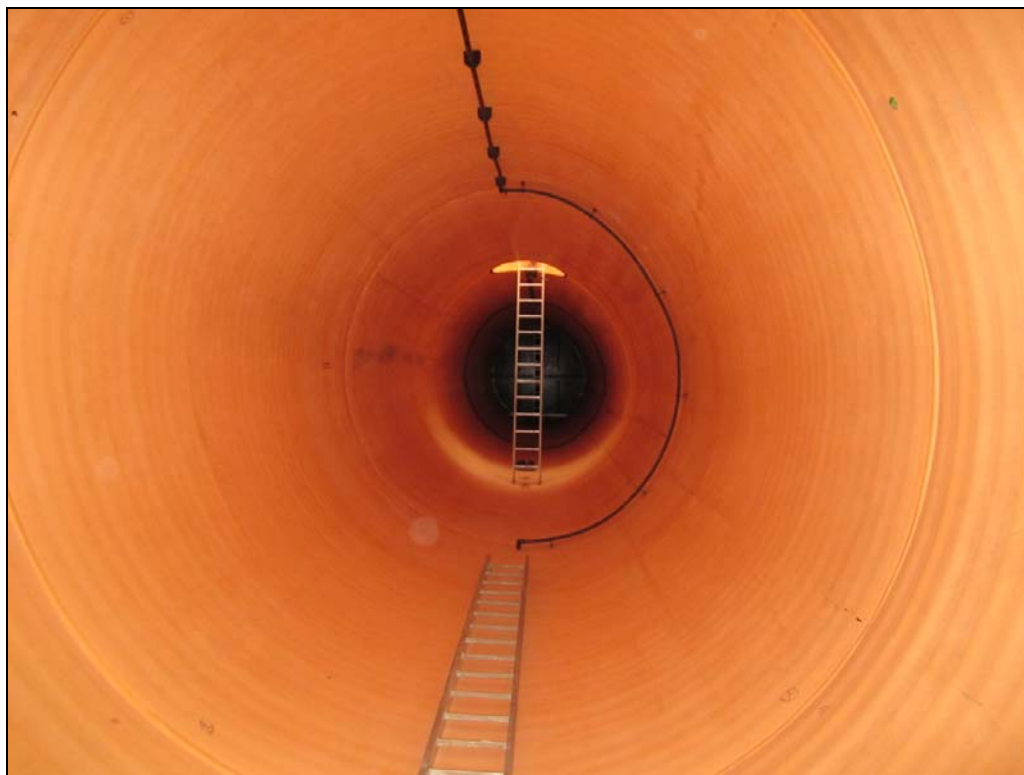
Bild 4: Ovalisierung eines Sickerwasserspeicherrohres in vertikaler Richtung
