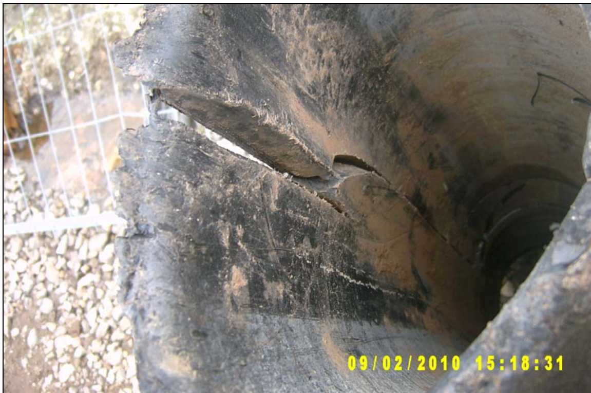
Bild 2: Gerissenes PE Rohr
