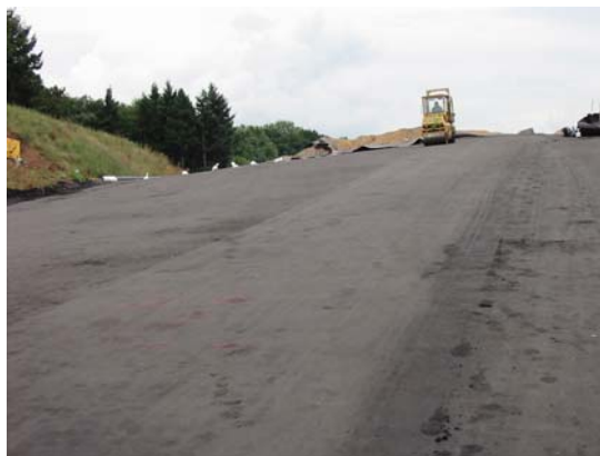
Bild 2: Herstellen der Oberfläche der mineralischen Dichtung
