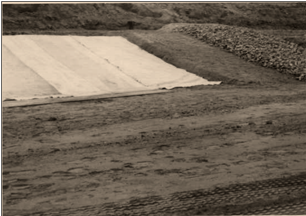
Bild 1: Versuchsfeld fur eine Flussverlegung mit PVC-weich-Bahnen 1976
