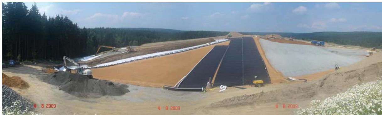
Bild 9: Technologisch gut geordnete Baustelle einer Deponieoberflachenabdichtung in Kombinationsbauweise
