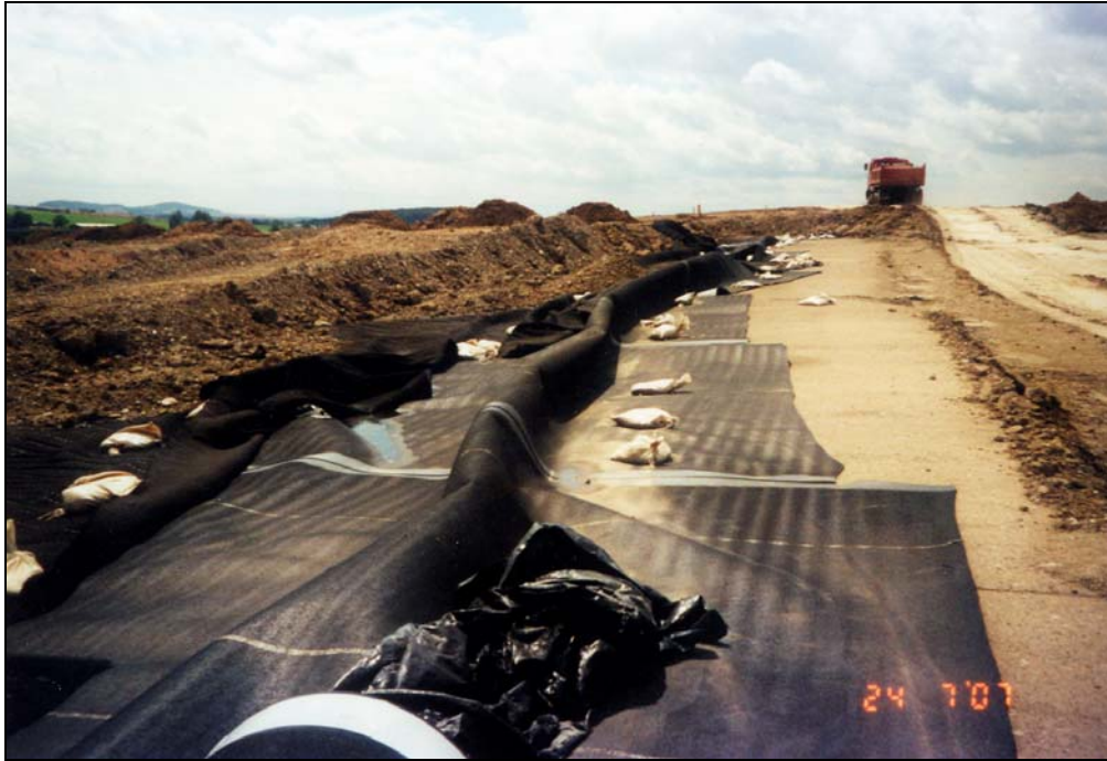
Bild 6: Durch ein Witterungsereignis beeintrachtigter Anschlussbereich einer verlegten KDB mit Dranagematte
