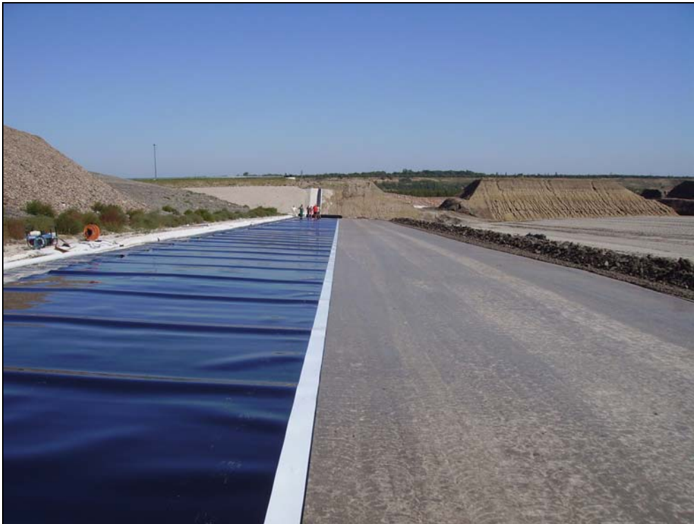
Bild 5: Vorbildliches Verlegeplanum (Oberflache einer mineralischen Dichtung)
