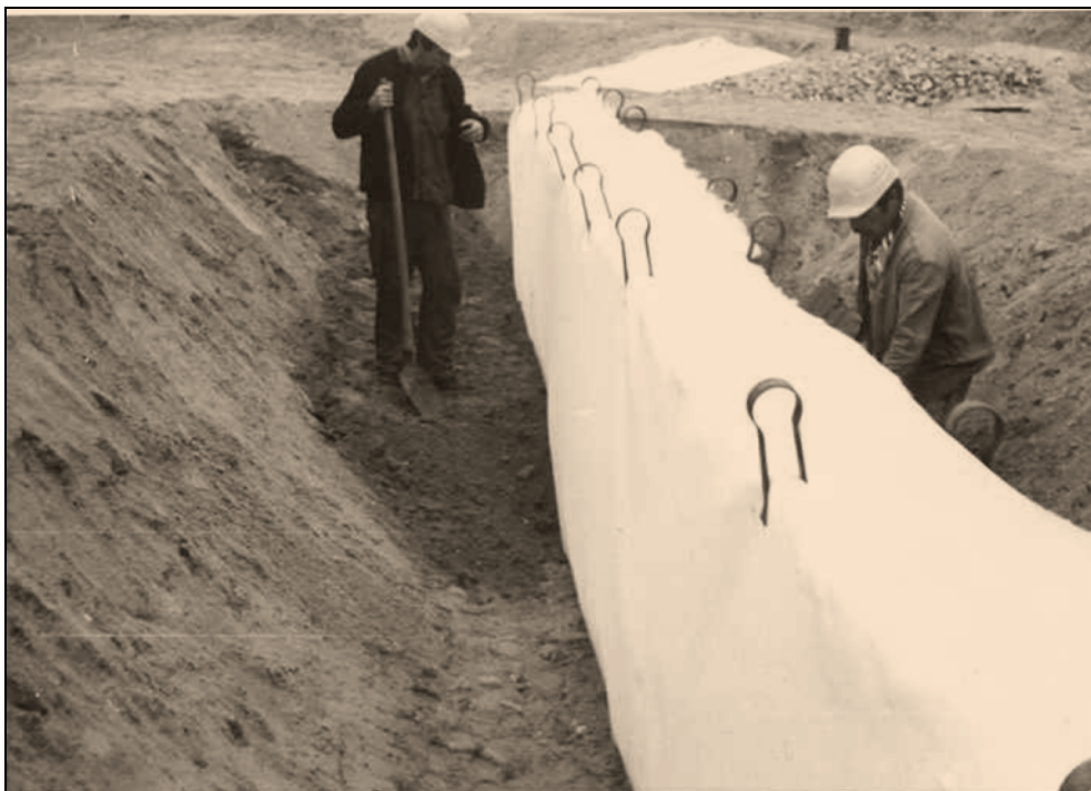
Bild 2: Einbau einer doppellagigen und kontrollierbaren Kerndichtung aus PVC-weich-Bahnen 1983
