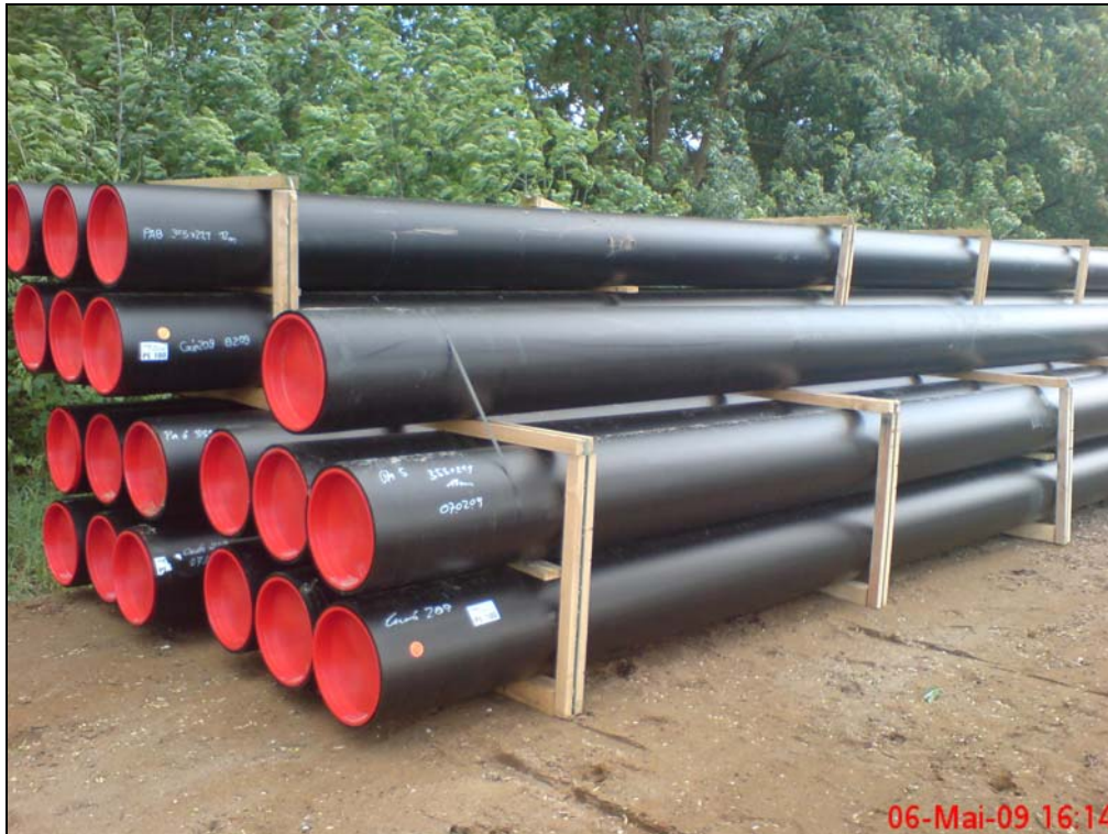
Bild 7: Fachgerechtes Zwischenlager fur Rohre auf der Baustelle
