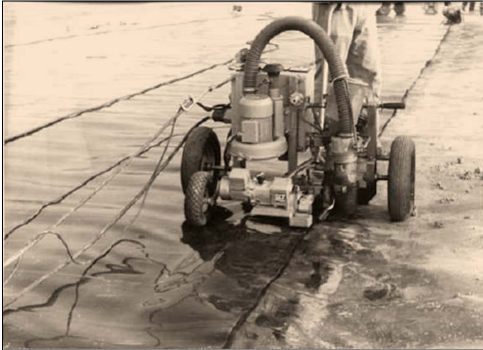
Bild 4: Schweigerat fur PE-HD-Bahnen 1987 fur die Manahme nach Bild 3
