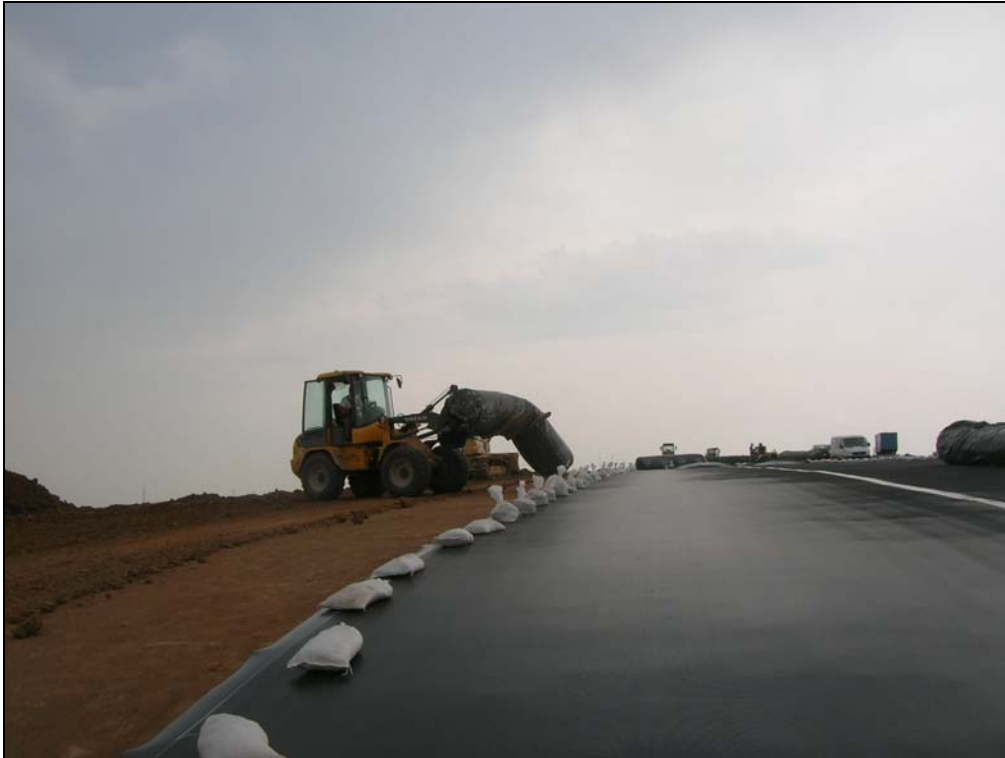
Bild 8: Mangelhafter Zwischentransport von Dranagematten
