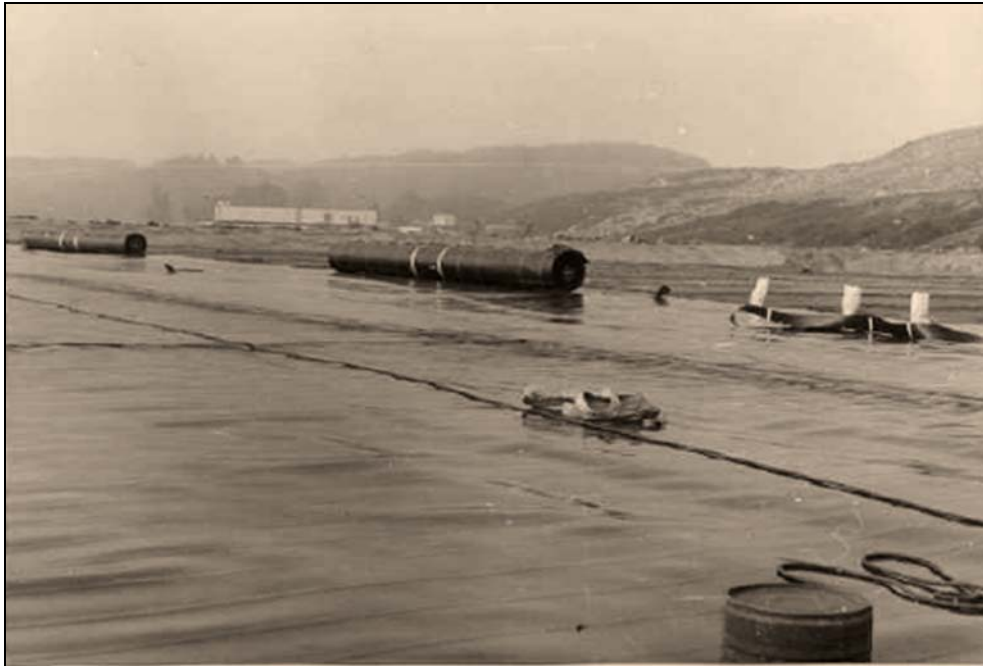
Bild 3: Basisabdichtung mit PE-HD-Bahnen als Kombinations-dichtung 1987 an einer Deponie im jetzigen Mecklenburg-Vorpommern
