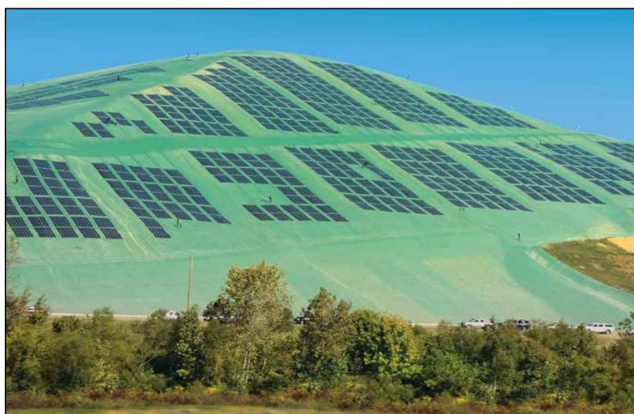
Abbildung 12: Auf einer Deponieoberflächendichtung aufgebrachte Solarzellen (Gupta und Morris, 2013)
