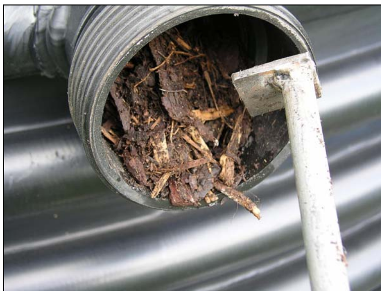
Bild 6: Probenahmestutzen mit Entnahmestange
