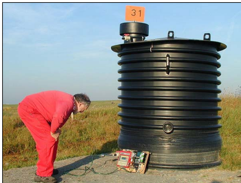
Bild 5: Rohgasmessung unten am Biofilter
