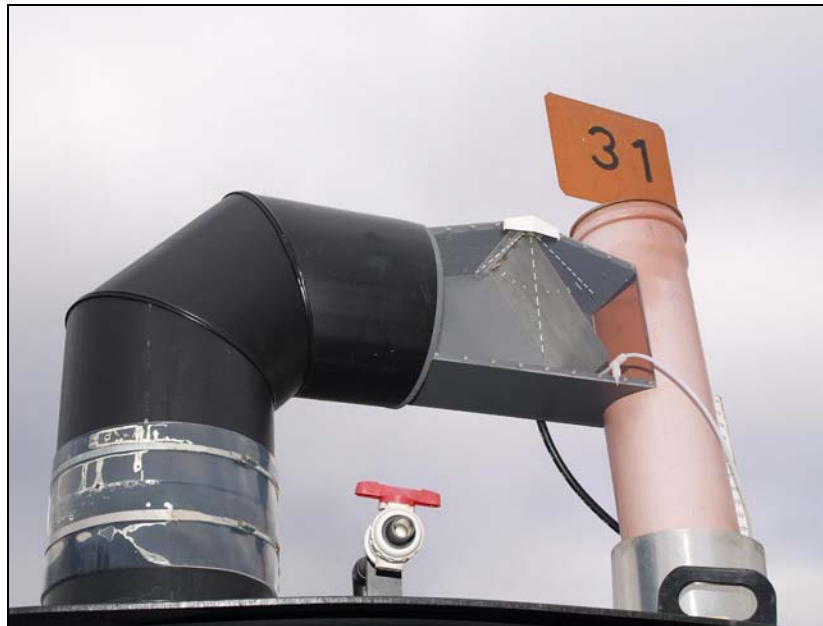
Bild 13: Richtungsmesskammer im Dauerbetrieb
