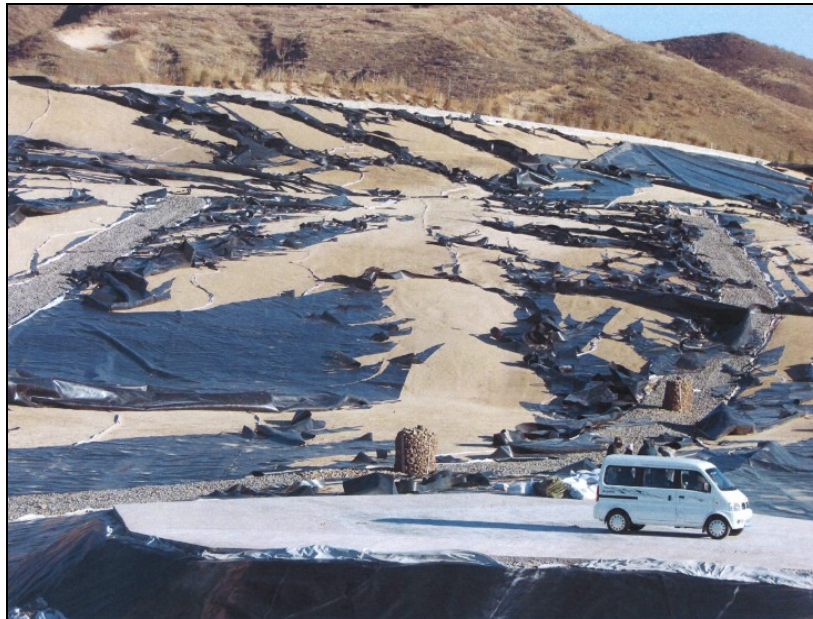
Abbildung 1: Schaden an einer PEHD-Dichtungsbahn durch Spannungsrissversagen (Bild von GSE Lining Technology)
