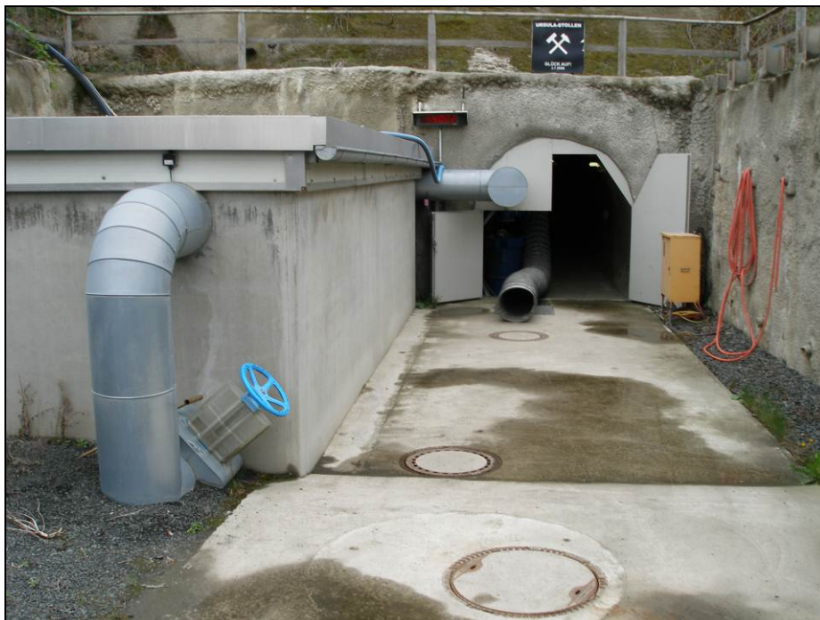
Abbildung 4: Tanklager am Ausgang des Entwässerungstollens
