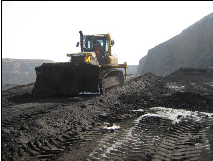
Abbildung 2: Mechanischer Einbau der mineralischen Abfälle
