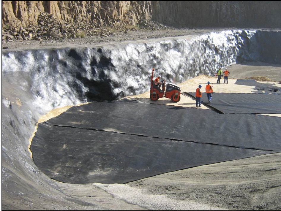
Abbildung 7: Verlegung der KDB (rauh)
