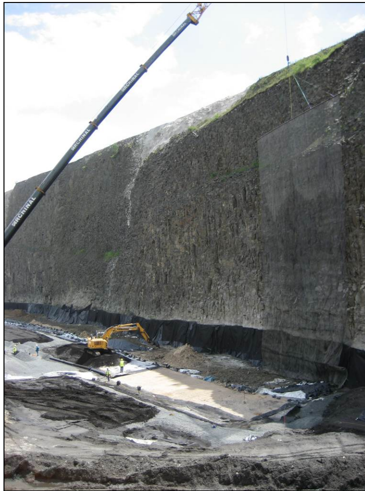
Abbildung 11: Steinschlag-Sicherung mit Autokran und Schutznetz
