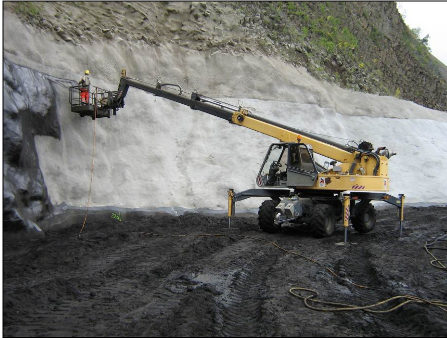
Abbildung 10: Herstellung der Felswandabdichtung mit KMB
