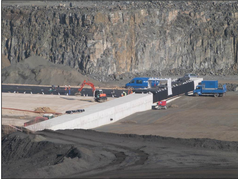
Abbildung 13: Dichtungsbau im Baufeld 5, Bildmitte: Kontrollgang (L=135 m)
