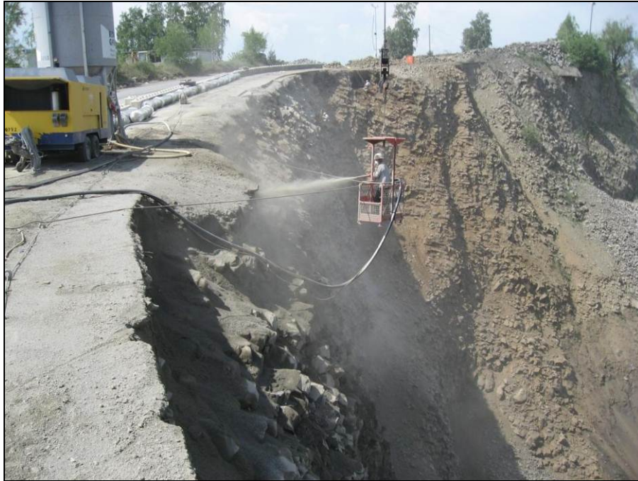
Abbildung 12: Steinschlag-Sicherung / Aufbringen von Spritzbeton an Steilwand
