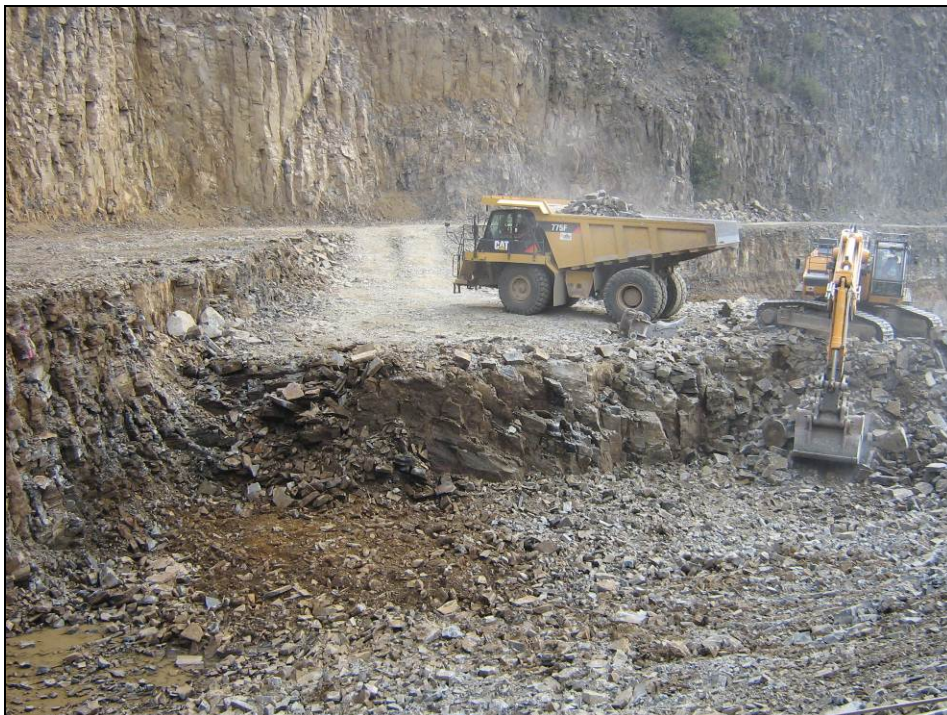
Abbildung 5: Aussteinerung für die Deponieerweiterung
