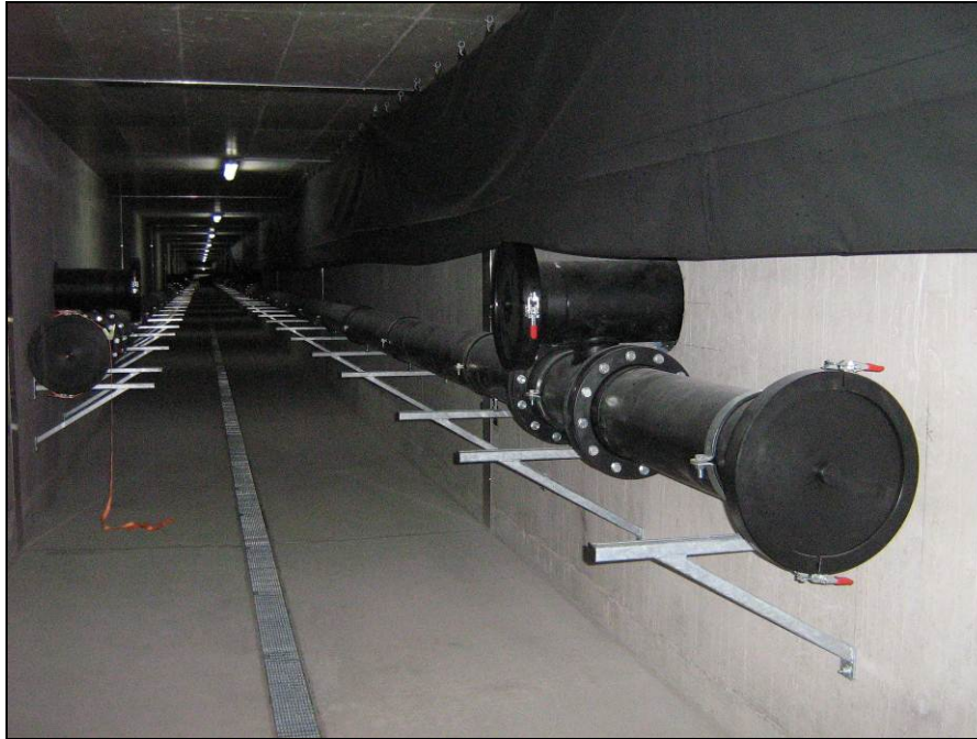
Abbildung 8: Peripheriebauwerk- Kontrollgang für die Deponieentwässerung
