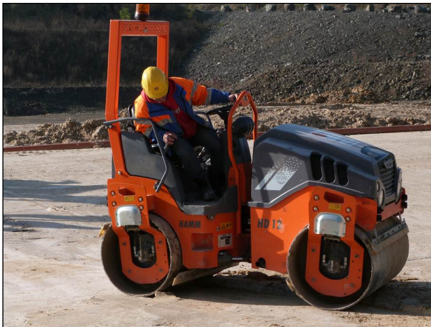
Abbildung 6: Einbau der geologischen Barriere (Ton)
