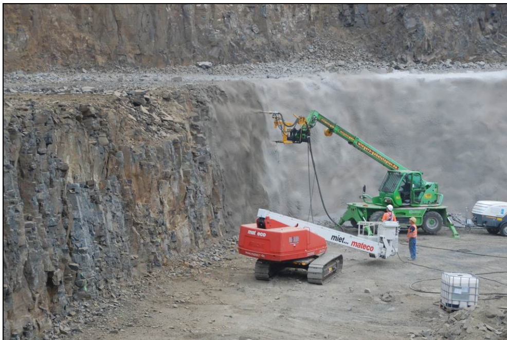
Abbildung 9: Spritzbetonarbeiten zur Versiegelung der Felswand
