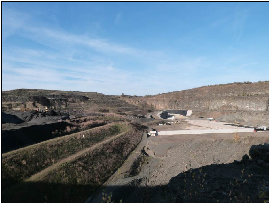
Abbildung 1: Übersicht der Deponie, links: aktive Abschnitte / rechts: Erweiterungsbereiche
