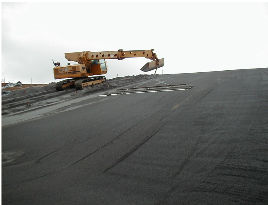
Bild 3: Glätten der Oberfläche des Kapillarblocks, Foto: Dr. Weiß, CDM
