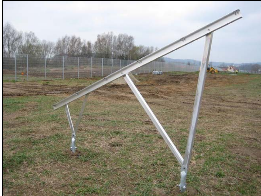
Abb. 8: Beispiel für ein Freiland-Rack (V-System) auf Drehfundamenten (K2-Systems)
