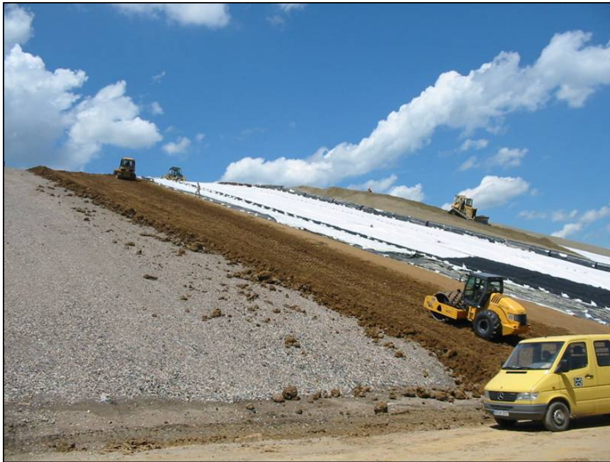
Abb. 4: Einbau des Oberflächenabdichtungssystems
