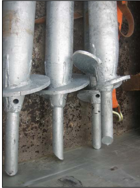
Abb. 7: Beispiel Drehfundament mit Wendelsystem (Fa. Doma)
