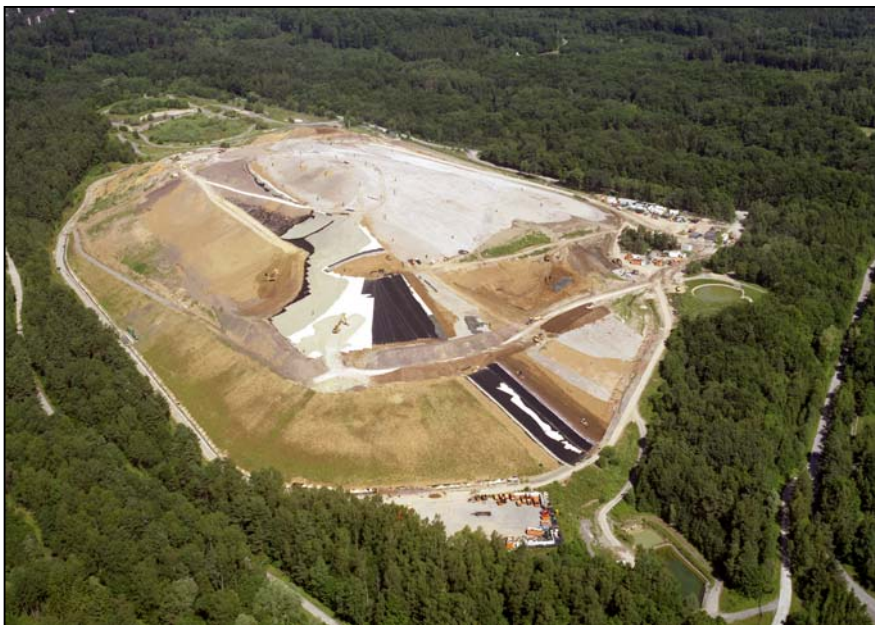
Abb. 1: Luftbild Deponie Böblingen, Blickrichtung Südost
