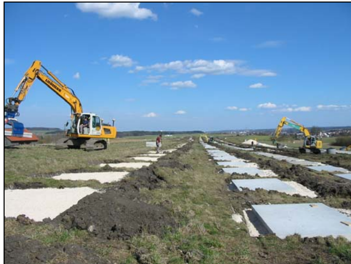
Abb. 6: Herstellung von Betonfundamenten in flach geneigter Oberfläche, Deponie Ulm-Eggingen
