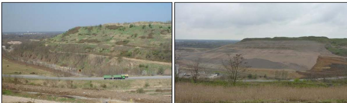
**Bild 3:** Südböschung des Altkörpers vor (linkes Bild: 2010) und nach Profilierung (rechtes Bild: 2012)
