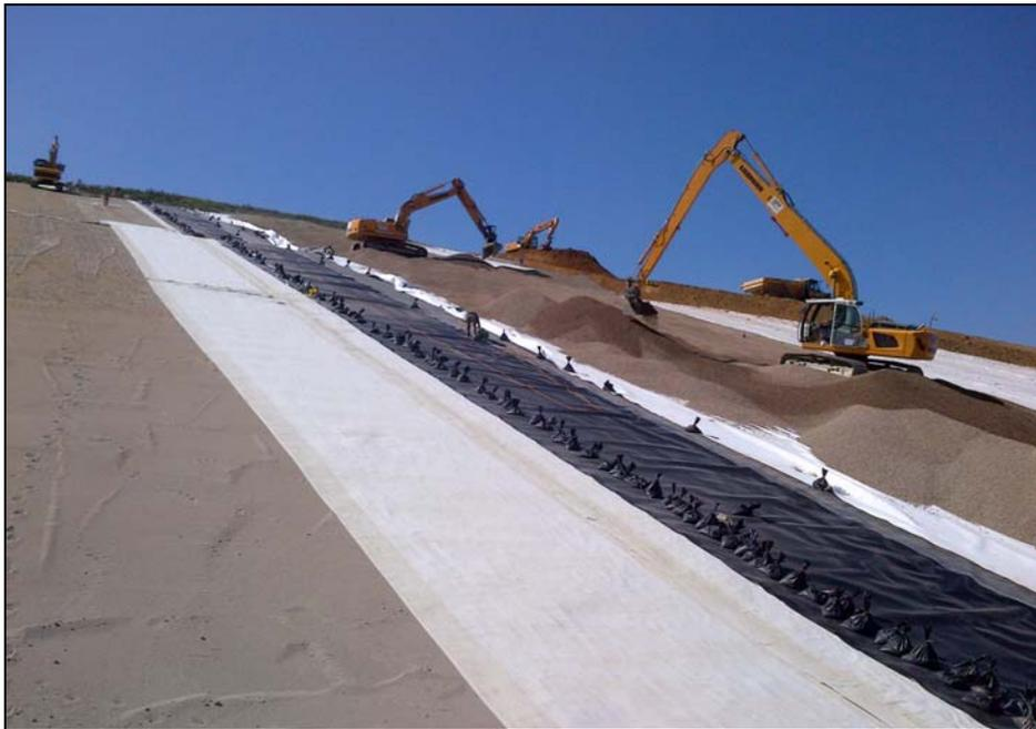
**Bild 2:** Schichtenfolge des Abdichtungssystems im 1. BA
