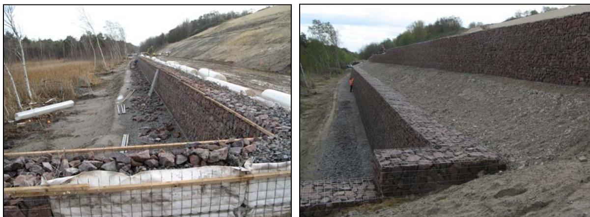
**Bild 5:** Stützbauwerk: im Bau (linkes Bild) bzw. fertiggestellt (rechtes Bild)
