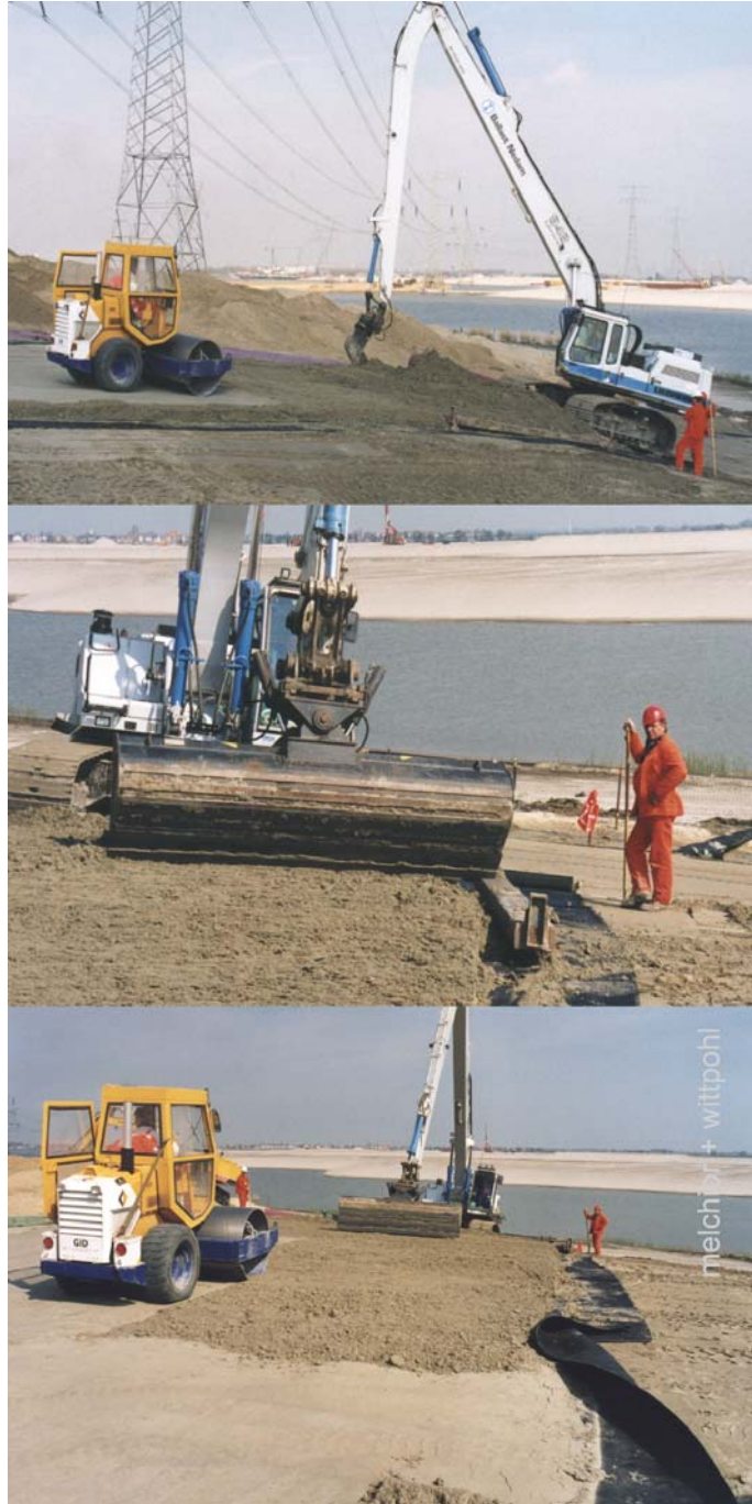
Bild 4 „Klassischer“ Einbau mit Langarmbagger und Walze
