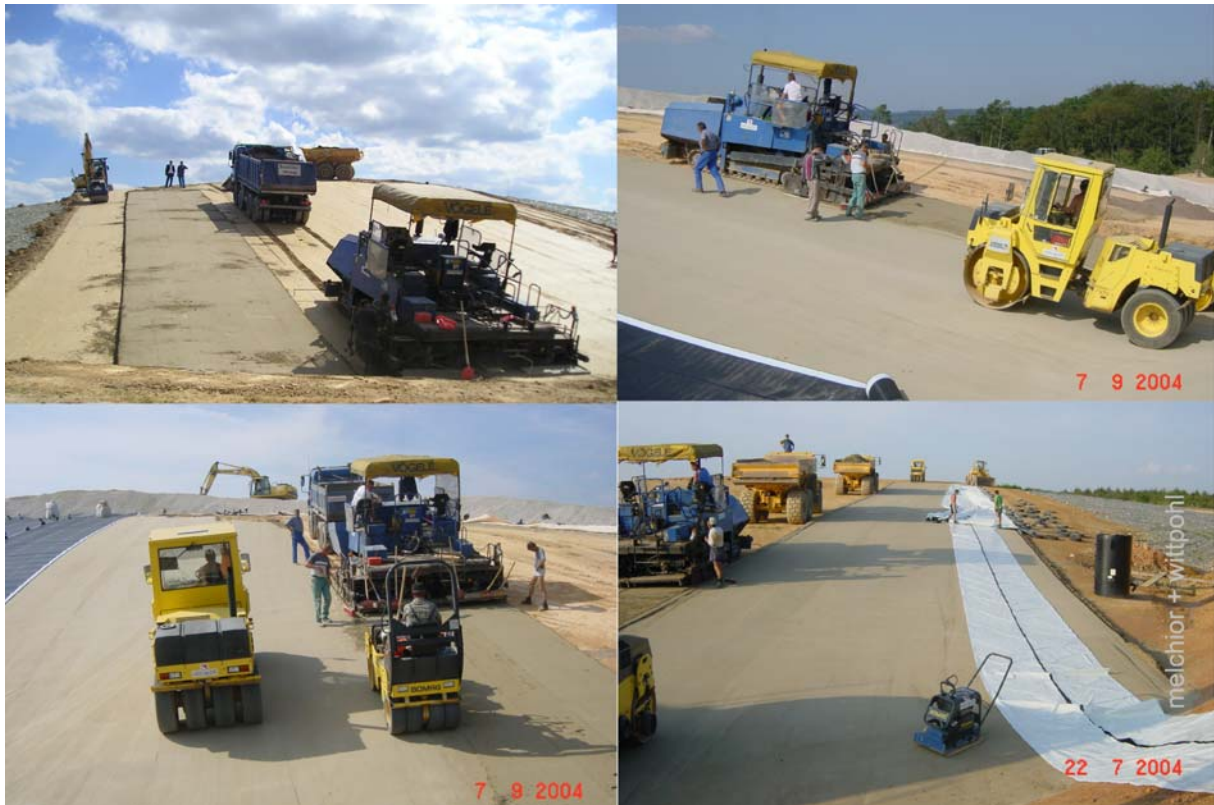
Bild 7 Mischgutverteilung und -verdichtung mit Fertiger und Walze
