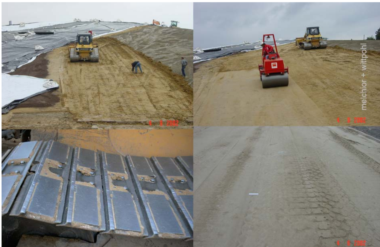
Bild 6 Mischgutverteilung und -verdichtung mit der Raupe
