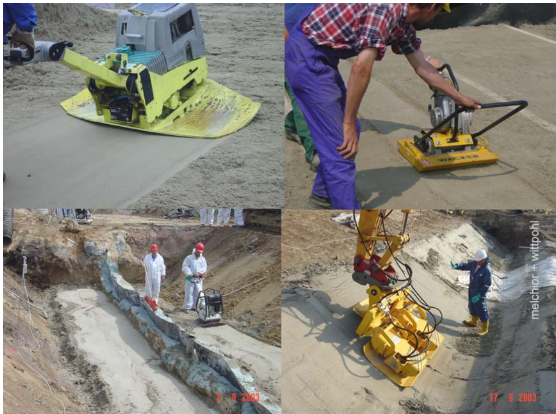
Bild 5 Verdichtung mit der Rüttelplatte
