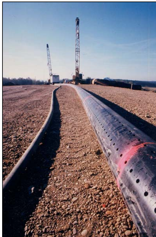
Bild 7: Oberirdisch verschweißter HDPE-Reliningstrang
