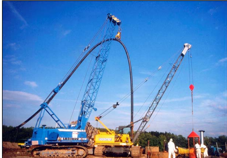
Bild 8: Einziehen des HDPE-Reliningrohrs.
