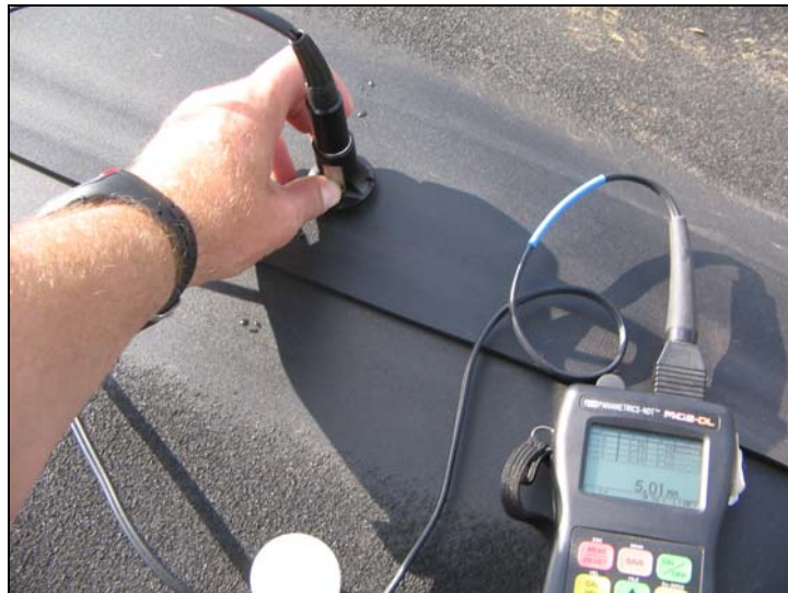
Bild 1: Ultraschallprüfung auf der Baustelle
