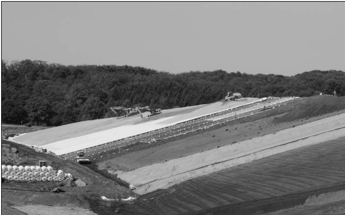
Abb. 9: Abdichtungsbau im MFA-BA1-West im August 2012
