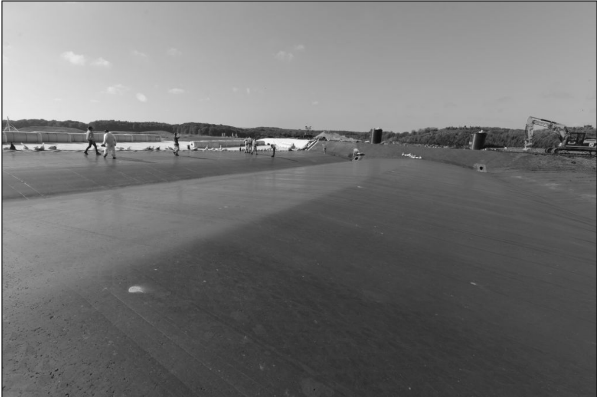
Abb. 10: Abdichtungsbau im MFA-BA2-West im September 2013
