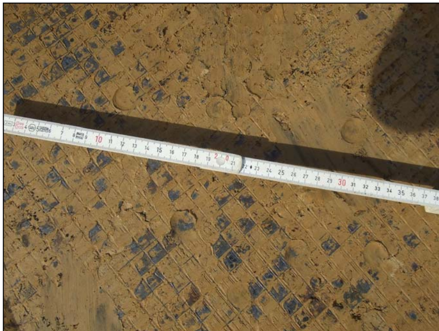
Abb. 11: Oberfläche der mineralischen Dichtung (Detail)
