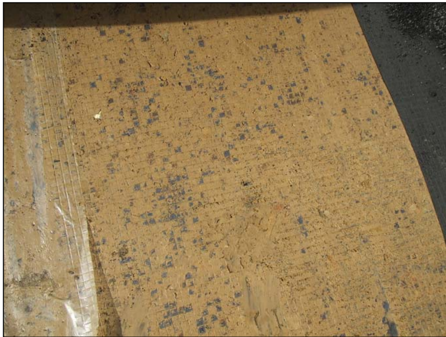
Abb. 10: Oberfläche der mineralischen Dichtung
