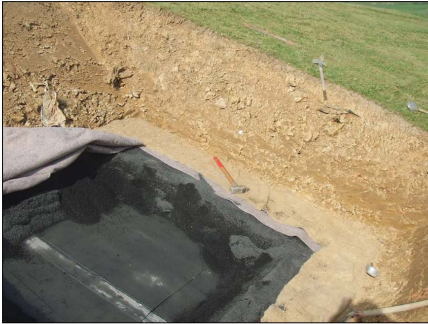
Abb. 8: Baggerschurf in der bestehenden Oberflächenabdichtung im Deponieabschnitt DA 1
