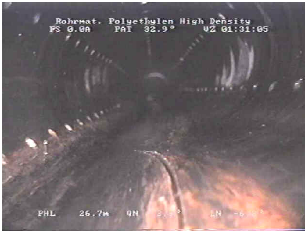
Abbildung 4: Risse im Sickerwasserrohr in der ungelochten Sohle [5]
