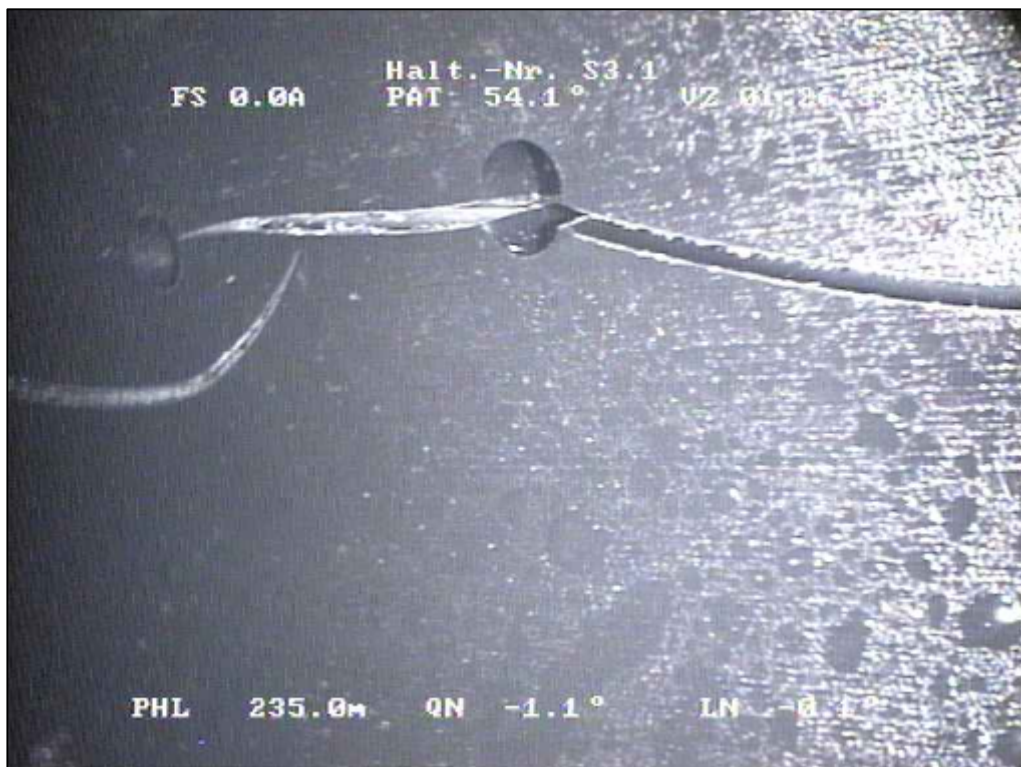
Abbildung 2: Längsrisse im Sickerwasserrohr gelocht [5]
