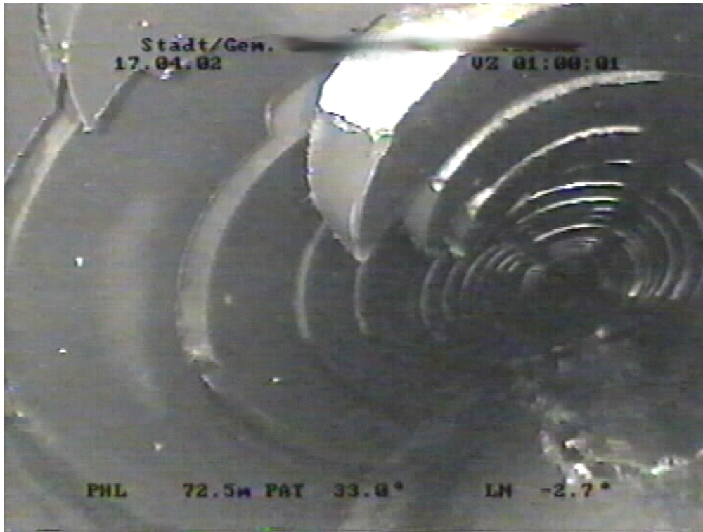
Abbildung 3: Risse im Sickerwasserrohr geschlitzt [5]
