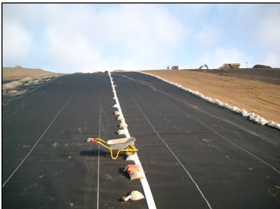
Bild 3.1.15/16 Bauablauf (TAG, KDB, Entwässerung) / Anschluss an Revisionsschacht
