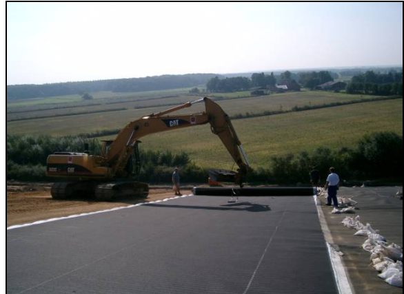
Bild 3.1.13/14 Einbau des Auflagers (TAG) und der PEHD-Dichtungsbahnen
