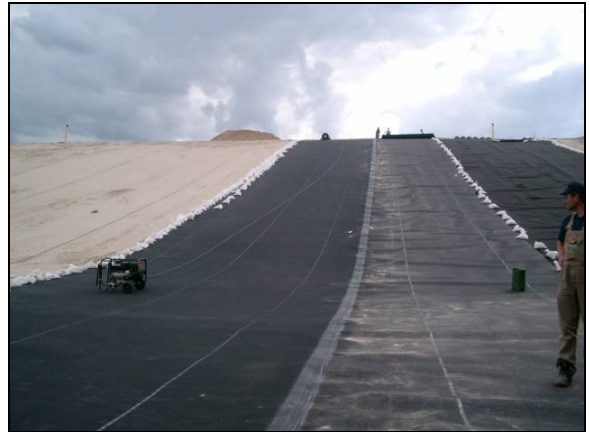
Bild 3.1.4/5 Übergang 1./2. BA sowie Installation von KDB und Schutzvlies
