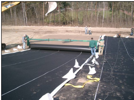
Bild 3.1.6/7 KDB-Verlegung im Böschungsbereich mittels Traverse bzw. Seilwinde
