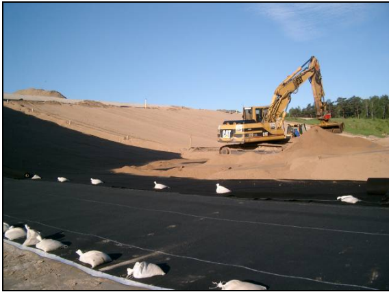
Bild 3.1.8/9 Vor-Kopf-Einbau der Drainageschicht / Randgrabenausbildung
