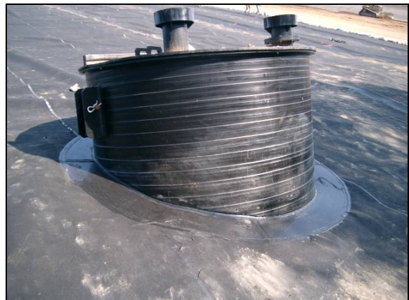
Bild 3.1.15/16 Bauablauf (TAG, KDB, Entwässerung) / Anschluss an Revisionsschacht
