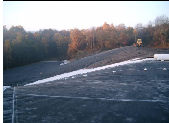
Bild 3.2.2/3 Einbau KDB-Auflager / Dichtungsbahn+Drainagematte+Kesselschlacke
