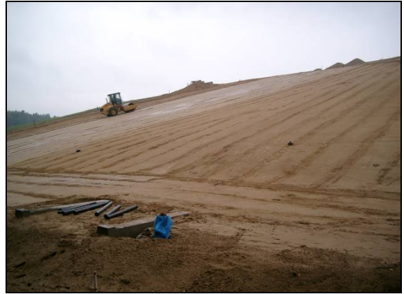
Bild 3.1.2/3 2-lagige Herstellung des Dichtungbahnaufagers
