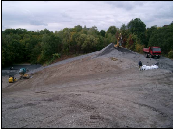
Bild 3.2.2/3 Einbau KDB-Auflager / Dichtungsbahn+Drainagematte+Kesselschlacke
