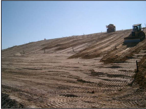
Bild 3.1.2/3 2-lagige Herstellung des Dichtungbahnaufagers
