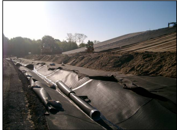
Bild 3.1.8/9 Vor-Kopf-Einbau der Drainageschicht / Randgrabenausbildung
