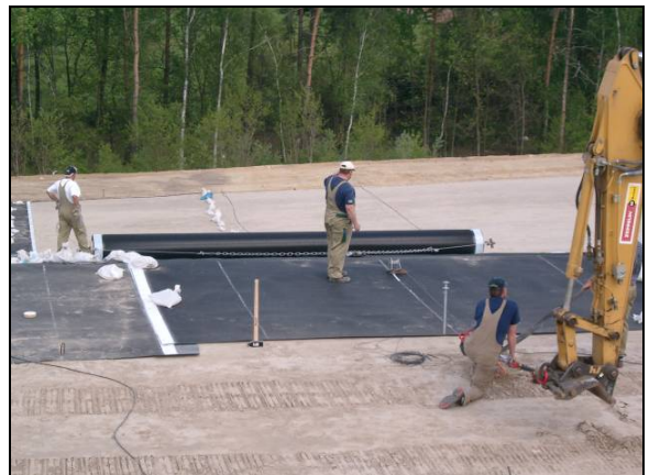
Bild 3.1.6/7 KDB-Verlegung im Böschungsbereich mittels Traverse bzw. Seilwinde
