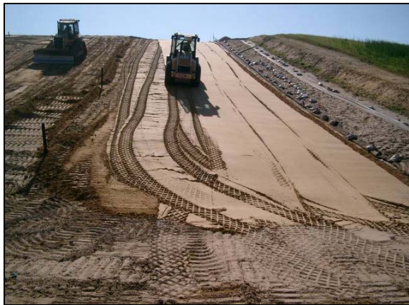
Bild 3.1.4/5 Übergang 1./2. BA sowie Installation von KDB und Schutzvlies
