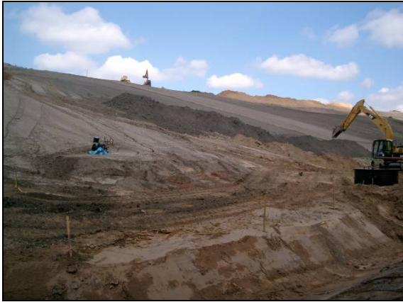
Bild 3.1.13/14 Einbau des Auflagers (TAG) und der PEHD-Dichtungsbahnen
