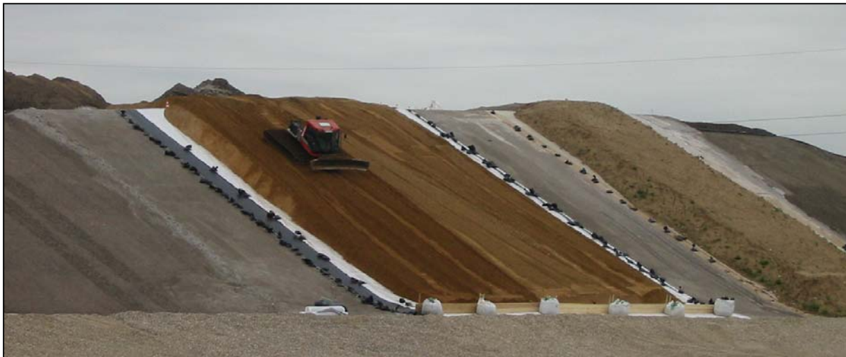
Abb. 1: Befahrung einer 1:n = 1:2 geneigten Oberflächenabdichtung
