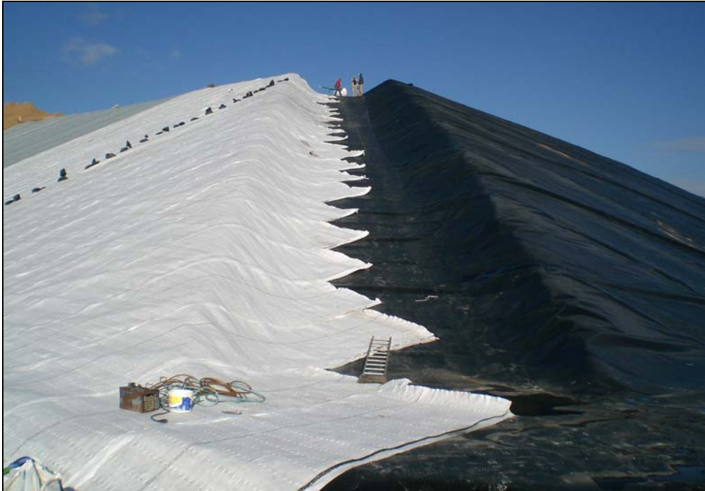
Abb. 5: Ausbildung eines Flankengrabens zur Verankerung des Geogitters im Kurvenbereich
