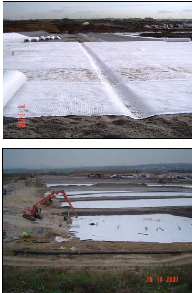
Abbildung 16: Verlegung KDB/Schutzlage
