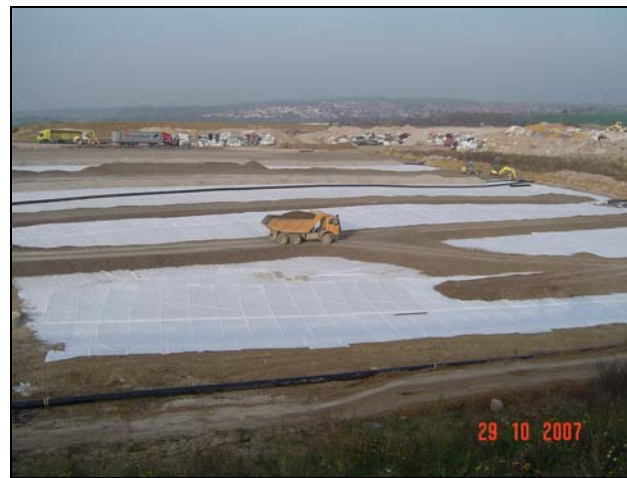
Abbildung 17: Detail Sickerwasserdrainagen/Entwässerungsschicht Gleisschotter
