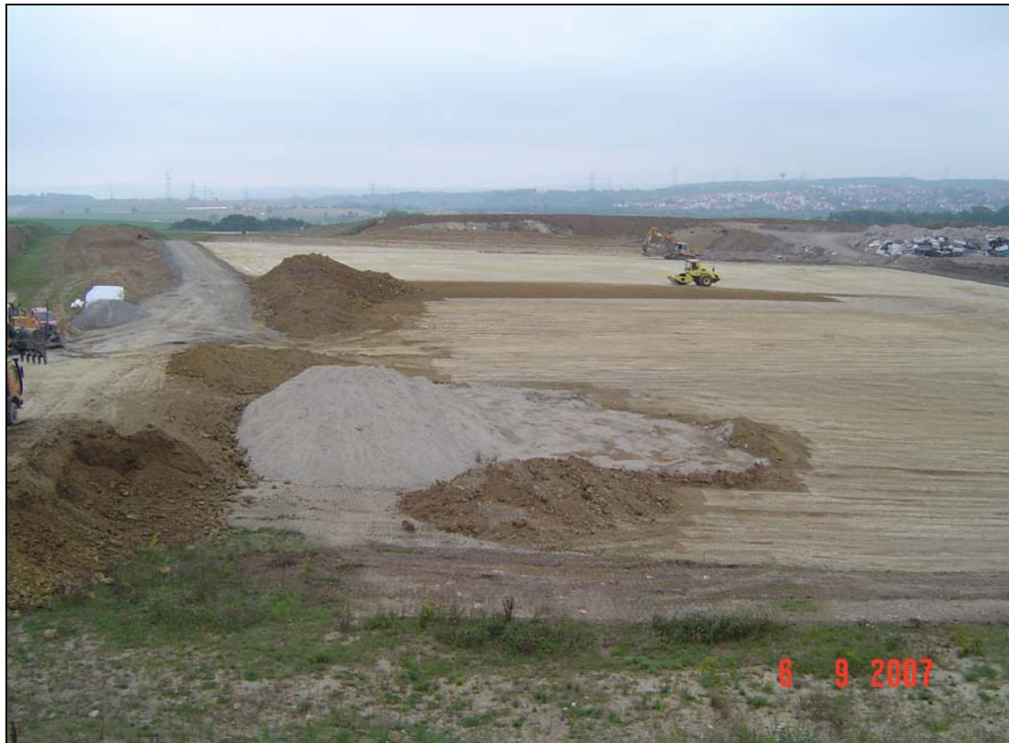
Abbildung 15: Vorbereitung des Dichtungsaufagers
