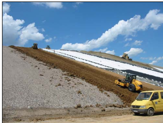
Abbildung 8: Verlegung Kunststoffdichtungsbahn Deponie Böblingen
