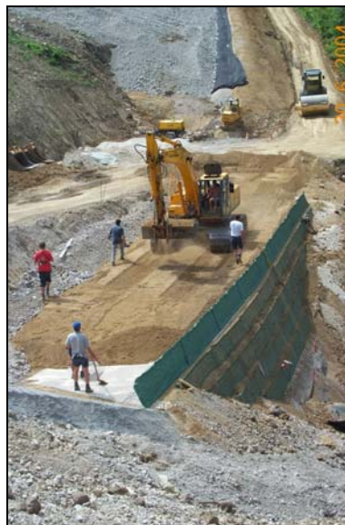
Abbildung 3: Einbau der Polsterwand
