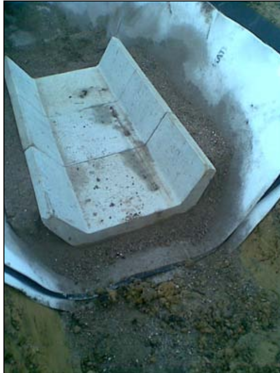
Abbildung 12: Randgraben für Oberflächenwasser
