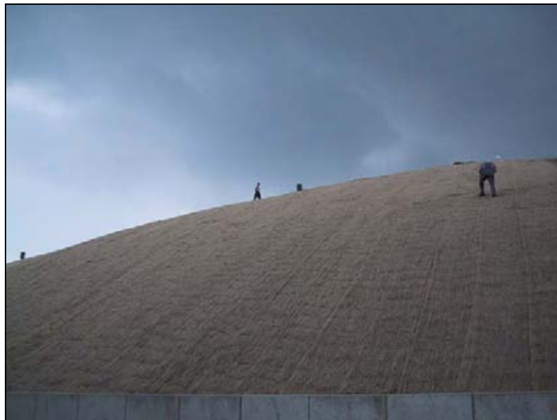
Abb. 3: Erosionsschutzmaßnahmen an der Oberflächenabdichtung der Deponie Furth im Wald (2005)
