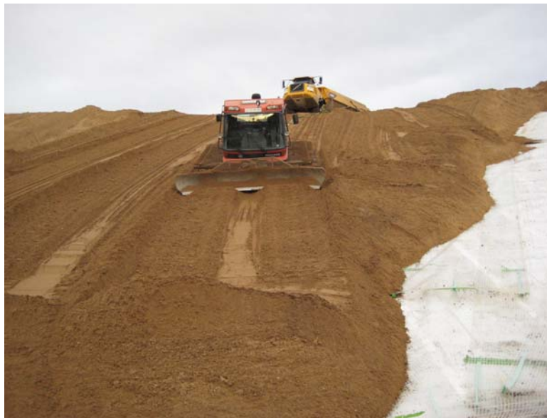
Abb. 6: Einschleppen des Unterbodens einer Rekultivierungsschicht mit Geogitter und Dränagematte auf einer 1:n = 1:2 geneigten Böschung mit Pistenbully
