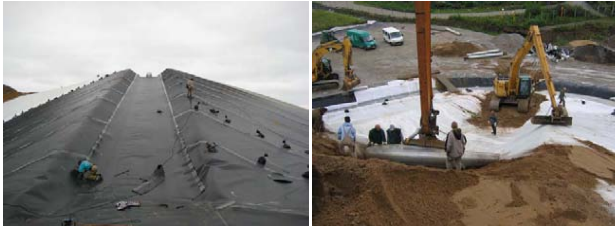
Abb. 5: Ausführung eines Geogitter-Verankerungsgrabens im Kurvenbereich
