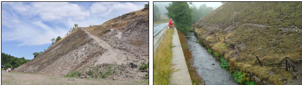
Abb. 1: Ausgangssituation der Pochsandhalde, rechts: Zellbach / Böschungsfuß
