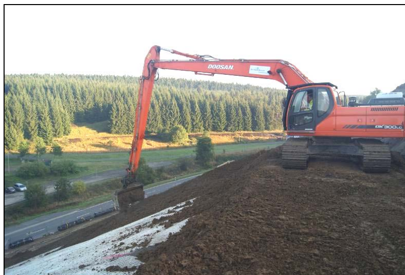
Abb. 7: Aufbringen des Rekultivierungsbodens mit Langarmbagger
