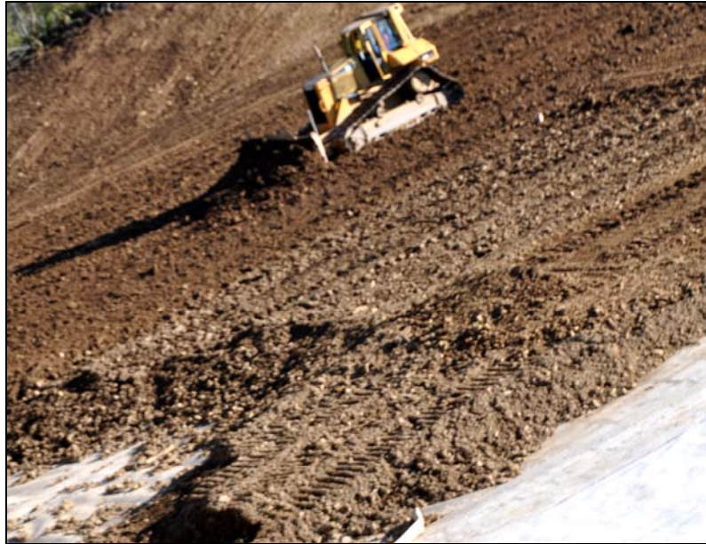
Abb. 8: Verteilen des Rekultivierungsbodens mit einer Planierraupe
